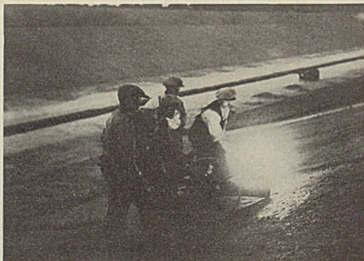
Abb. 18. Aufschmelzen poröser Stellen des Asphaltbelages durch Flammenwerfer.
