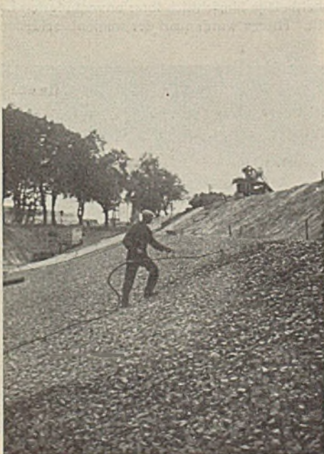
Abb. 9. Anspritzen der Schotterlage mit Asphaltemulsion.
