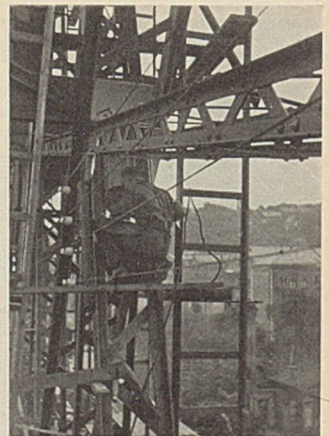
Abb. 9. Zugstrebenverstärkung.
