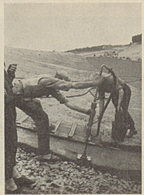
Abb. 11. Aufstampfen der Sandasphaltdecke auf die mit Asphaltmasse vergossene Schotterlage.
