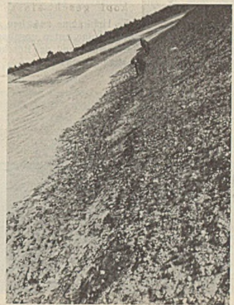
Abb. 13. Asphaltdecke, bestehend aus Basaltschotter mit zweimaligem Asphaltmastixverguß (rauhe Oberfläche). Zur Aufhellung der schwarzen Fläche ist etwas Kies aufgestreut.
