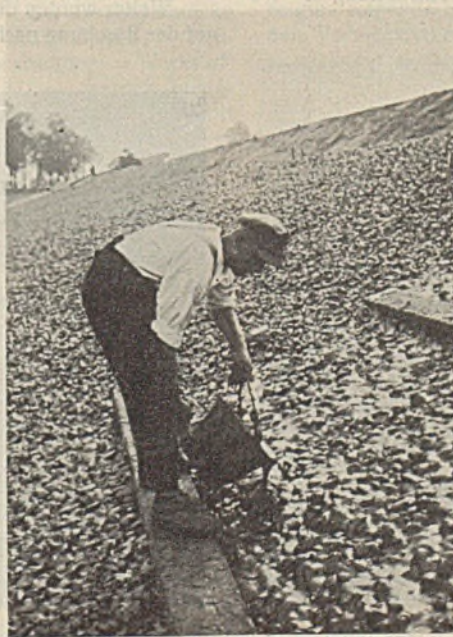
Abb. 10. Eingießen der Asphaltgußmasse in die Schotterlage.
