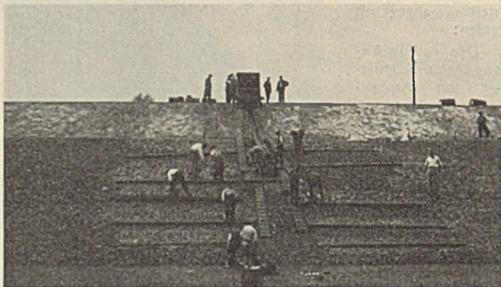
Abb. 15. Vergießen der Schotterlage mit Asphaltmasse.
