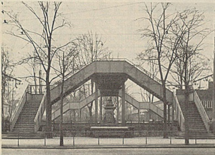
Abb. 3. Ansicht von der Stirnseite.
