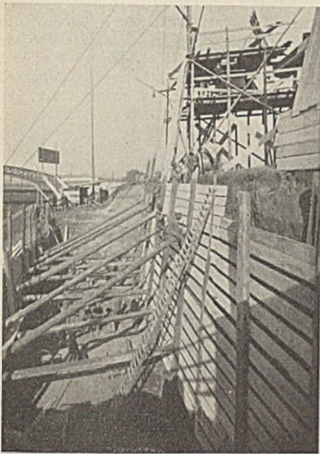
Abb. 11. Ausschachtungsarbeiten am Widerlager 5.
