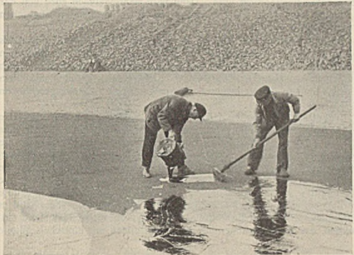
Abb. 5. Spramexieren der Dichtungsschicht.
