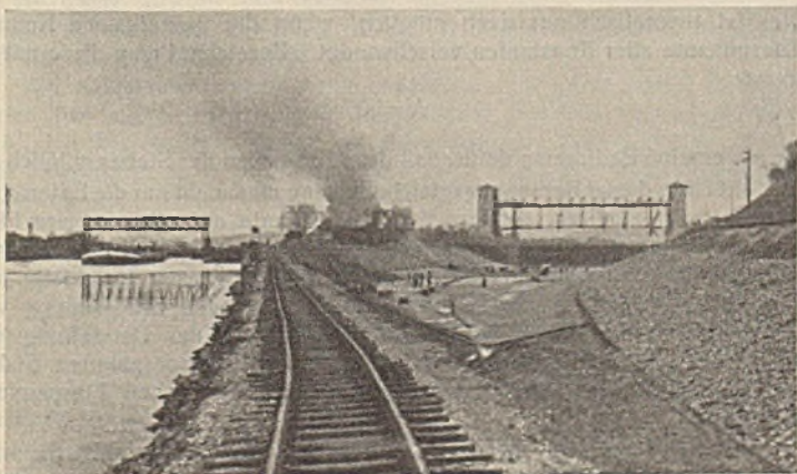
Abb. 11. Fertiggestellte Dichtung der Kanalsohle südlich des Sicherheitstores Datteln der 2. Fahrt bei Olfen.
