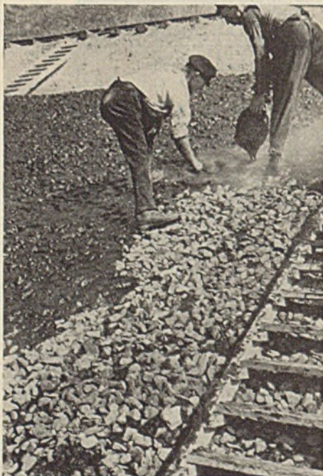
Abb. 7. Zweiter Einguß der Mastixvergußdecke.
