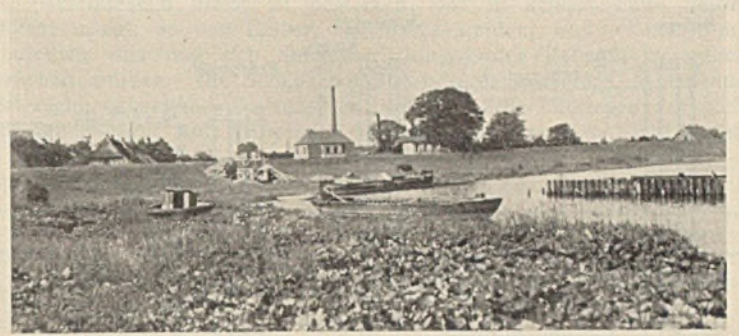
Abb. 6. Zustand der Baustelle vor der Aufspülung.
