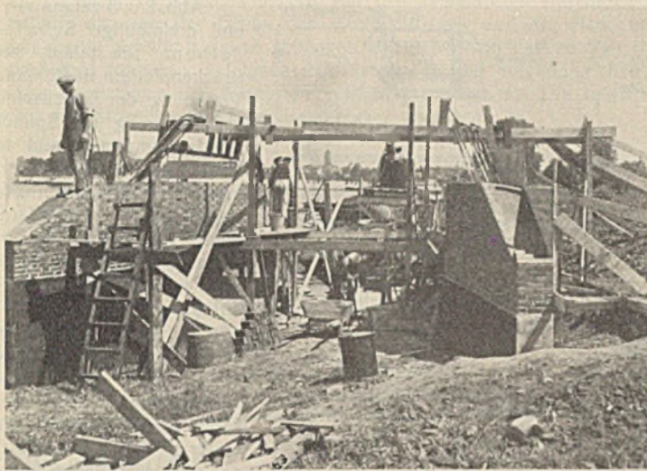
Abb. 5. Verankerung in der Deichschartmauer.
