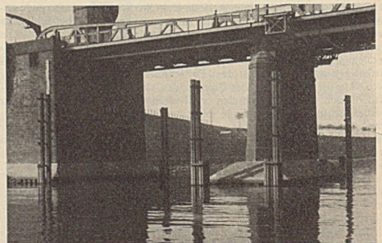
Abb. 4. Schutzdalben vor den Pfeilern der Oberbürgermeister-Lehr-Brücke II in Duisburg-Ruhrort.
