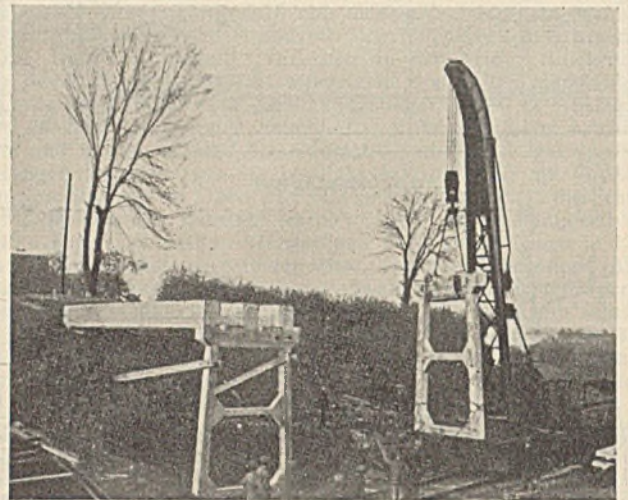
Abb. 4. Bau der neuen Brücke.
