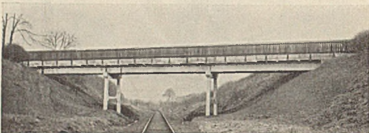
Abb. 2. Die neue Brücke.
