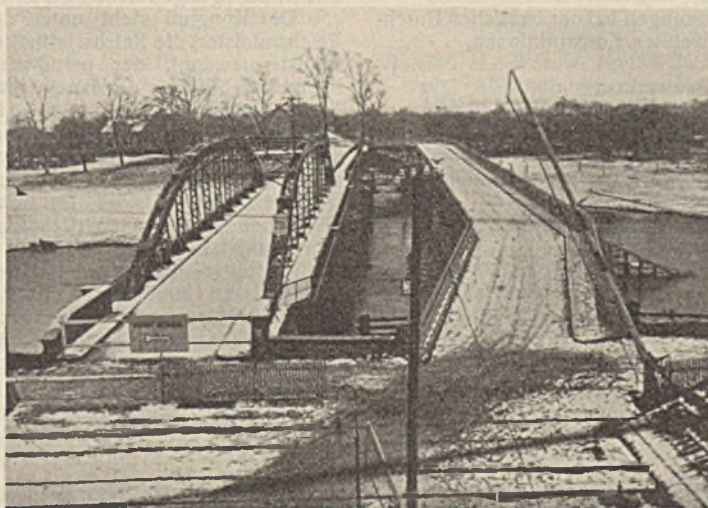
Abb. 15. Alte Brücke mit Notbrücke von der Stadtseite gesehen.
