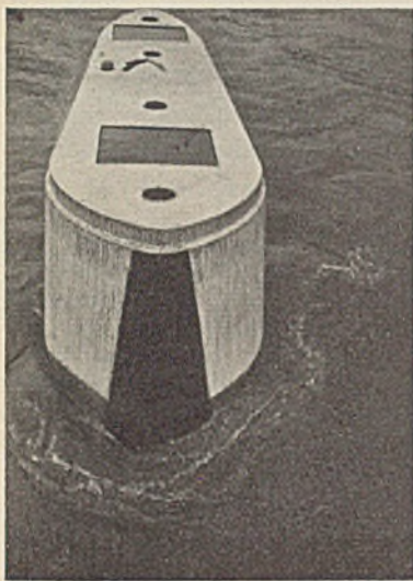
Abb. 7. Neuer Mittelpfeiler. Oberes Ende am 26. März 1933. (Wasserstand: Pegel Höxter + 6,10 m.)
