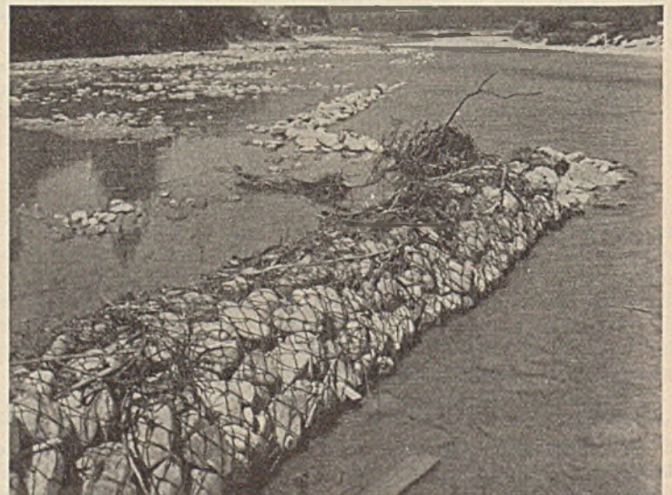
Abb. 14. Bühnenbau aus einer Drahtnetzwalze in der Jachen.
