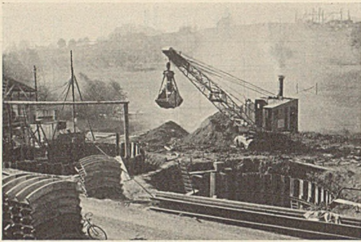
Abb. 29. Aushub der Pfeilergründung.
