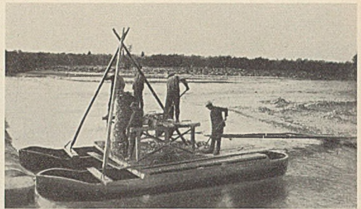
Abb. 5. Füllen eines Drahtnetzsackes.
