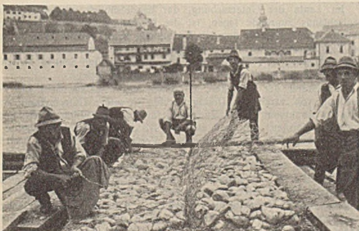
Abb. 30. Herstellung der Drahtnetzbehälter bei einem Bühnenbau in der Drau bei Pettau 1927.
