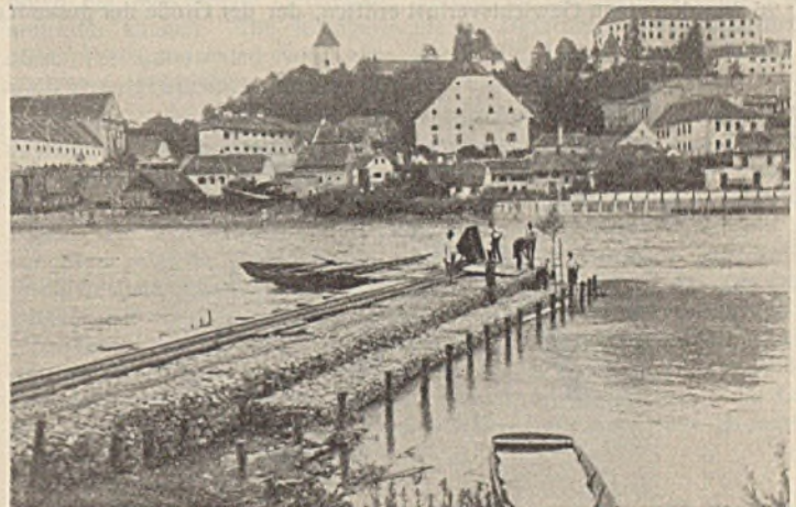
Abb. 31. Bühnenbau aus viereckigen Drahtnetzbehältern in der Drau bei Pettau 1927.
