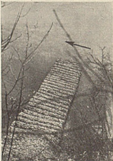
Abb. 10. Ansicht des Bühnenbaues in der Drau nach dem 1. Baujahr.
