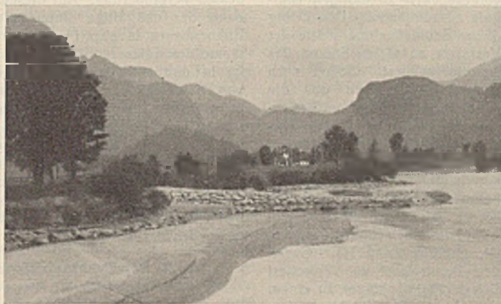
Abb. 7. Bühnentyp der Salzachregelung zwischen Bruck und Hallein.
