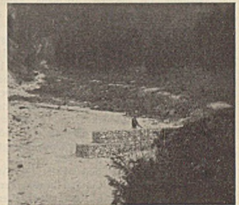
Abb. 19. Bühnenbauten (Spornbauten) im Röhgraben, Frauenweißenbach, Salzkammergut.
