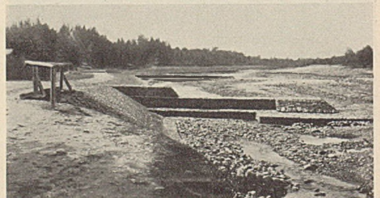
Abb. 23. Bühnenbauten aus viereckigen Drahtnetzbehältern. Bühnen nach der Fertigstellung.
