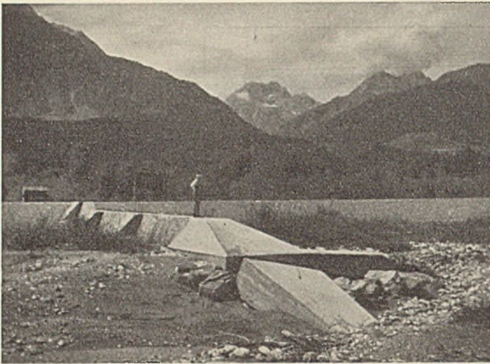
Abb. 11. Betonbühnenbau bei der Gall-Regelung, Kärnten.
