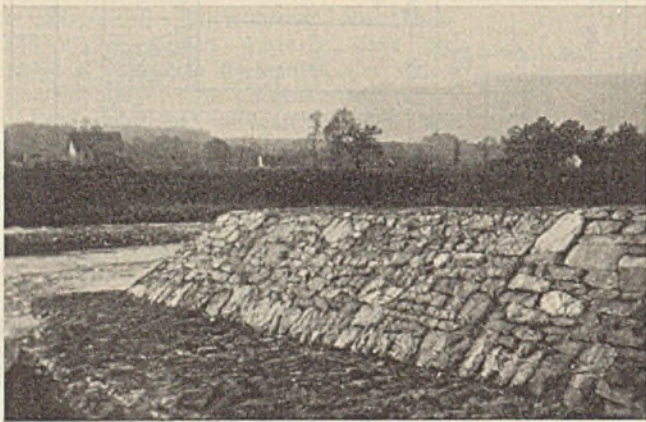
Abb. 28. Ansicht des mit Drahtnetzkörpern gesicherten Kopfes einer Steinbühne (Abb. 27).
