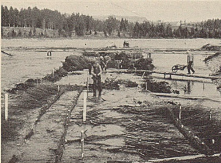
Abb. 12. Lech bei km 159,6. Blick flußabwärts; im Vordergrund unbekannter Faschinenbau; im Hintergrunde werden Grundlagen aus kurzwüchsigen Bergföhren in tiefes Wasser eingebaut.
