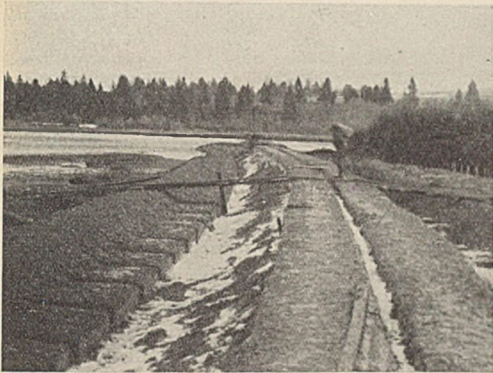
Abb. 19. Rechtseitiger Leitwerkbau bei Lech-km 143,0, flußabwärts gesehen.
