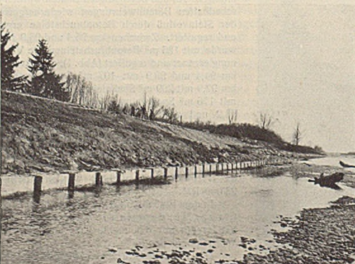
Abb. 6. Rechtes Illerufer bei km 27,8 mit Vorlagquadern vor der Versteinerung.
