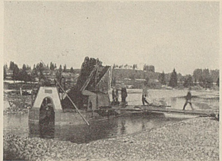
Abb. 20. Ausbaggern des Durchstiches bei Lech-km 142,9.
