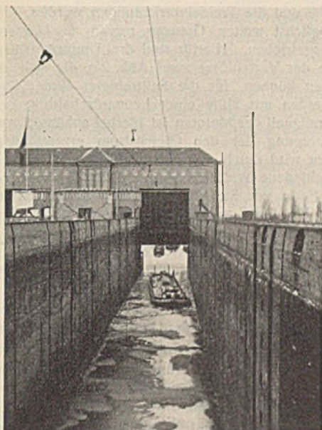
Abb. 19. Südkammer. Blick auf das Untertor.
