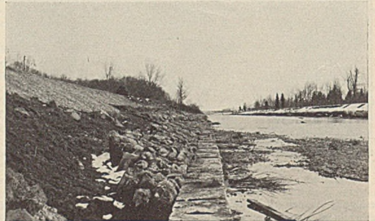
Abb. 8. Rechtes Illerufer bei km 27,9. Ansetzen der Spaltsteine an die Vorleger.
