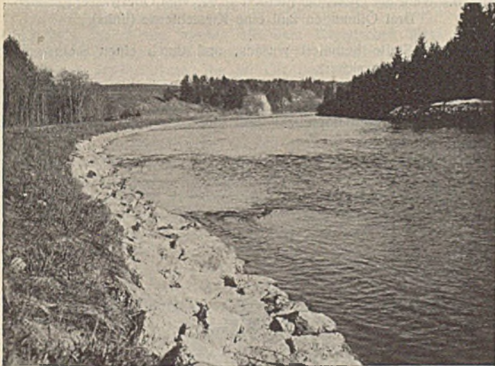
Abb. 1. Versteinerung mit Betonspaltsteinen an der Iller zwischen km 95,4 und 95,9.
