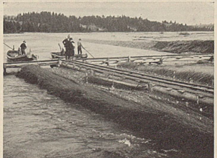
Abb. 13. Baustelle wie Abb. 12; Blick flußaufwärts. Faschinatbau beklet bei Lech-km 159,6.
