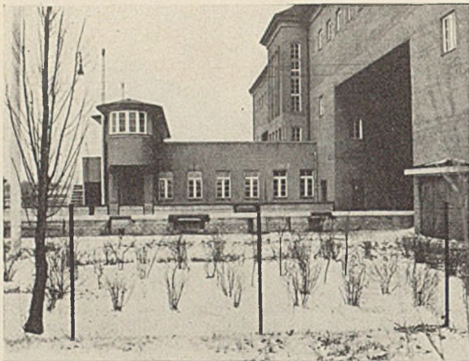
Abb. 13. Unterhaupt. Aufbauten. Links Befehlsbühne.
