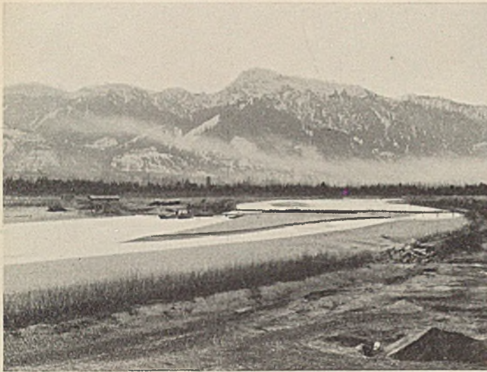
Abb. 10. Anbruch des Lech bei km 159,6 rechts; Blick flußaufwärts.
