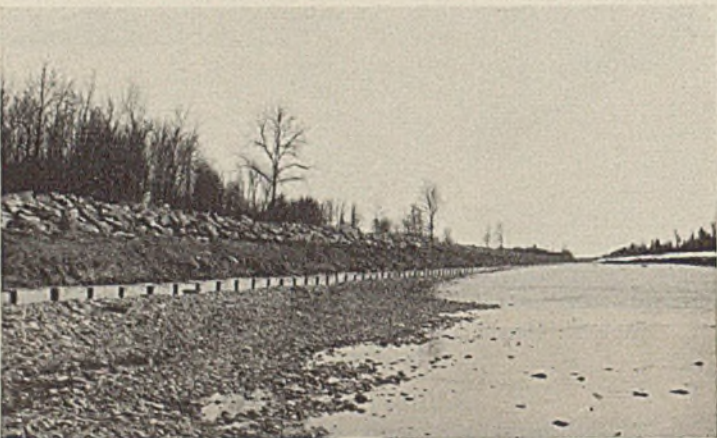
Abb. 7. Rechtes Illerufer bei km 27,8 mit fertigen Betonspaltsteinen an der Böschung lagernd.
