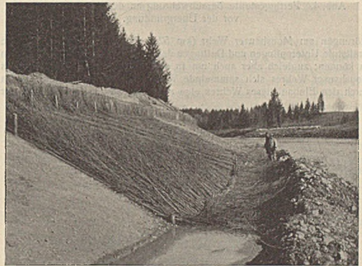
Abb. 2. Herstellung von Berauhwerung an der Iller bei km 95,4.
