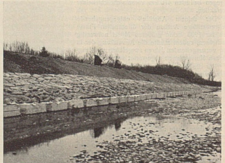
Abb. 9. Rechtes Illerufer bei km 27,8. Fertig versteinerte Böschung.
