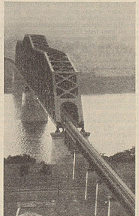
Abb. 3. Brücke der Chesapeake & Ohio-Eisenbahn über den Ohio-Fluß bei Sciotoville (zwei Öffnungen von je 236 m, durchlaufende Träger).
