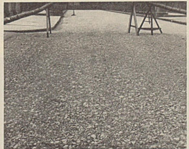
Abb. 5. Neu aufgewalzte Schotterdecke, zur Teerung vorbereitet.
