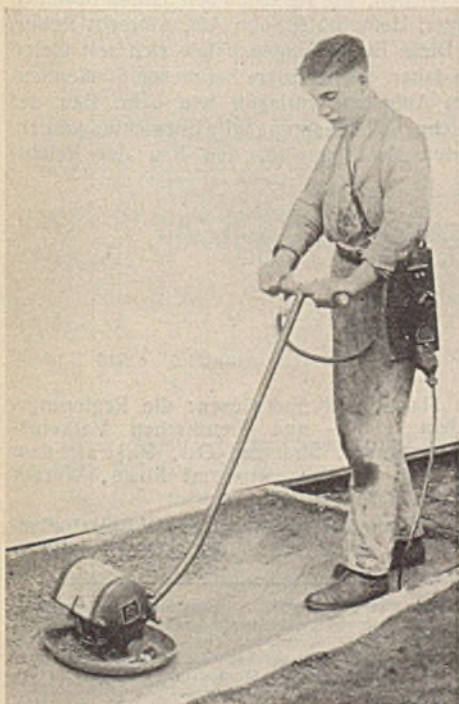
Abb. 5. Oberflächenrüttler für Betondecken. Rasche, sinusförmig verlaufende Schwingungen. Elektrischer Antrieb (0,2 kW). Gewicht 35 kg.
