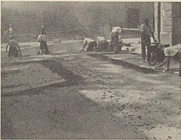
Abb. 11. Aufbringen einer Gußasphaltdecke auf Großpflaster.
