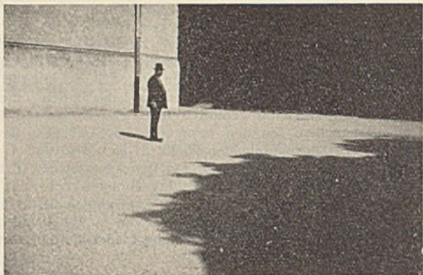
Abb. 4. Schulhof (Bodenvermörtelung). Kies und Sand mit Vialit H.
