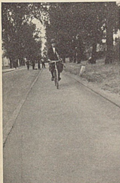
Abb. 2. Radfahrweg. Bodenvermörtelung. Kies mit Vialit H.
