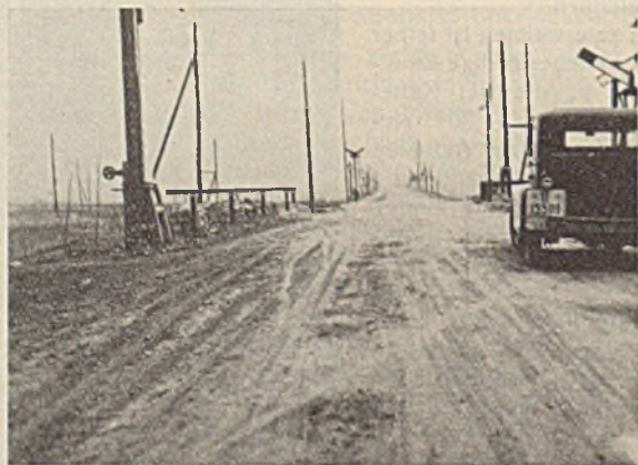
Abb. 7. Landstraße vor der Behandlung mit Vialit-Verschnittbitumen (Einbau im Herbst 1933, Aufnahme im Februar 1934).
