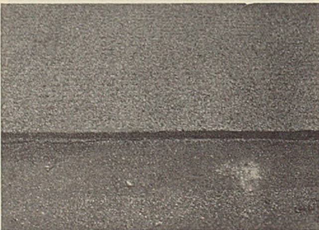
Abb. 9. Durch Einpressen von Basaltsplitt rau gehaltene Oberfläche von Gußasphalt.
