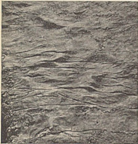
Abb. 2. Unebene Unterfläche einer auf nassem Lehm verlegten Platte.
