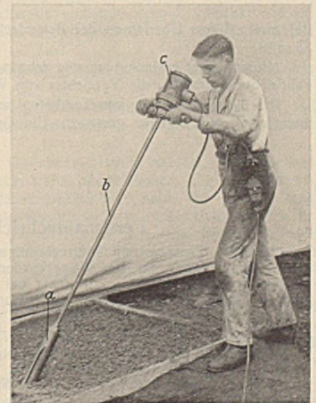
Abb. 6. Schwingungsrüttler für Tiefenwirkung. a Hohlkörper mit dem Schwingungserreger, b federndes Rohr mit Antriebswelle im Inneren, c Antriebmotor. Gewicht 16 kg.
