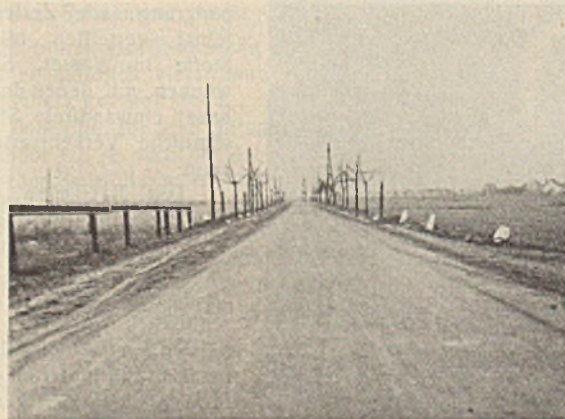
Abb. 8. Landstraße nach der Behandlung mit Vialit-Verschnittbitumen (Einbau im Herbst 1933, Aufnahme im Februar 1934).
