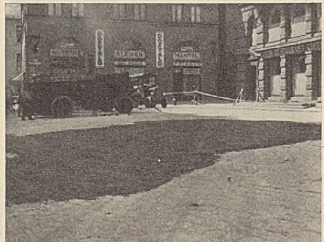
Abb. 10. Ausgleich der Unebenheiten einer alten Pflasterdecke durch Aufbringen einer Asphaltbinderschicht.
