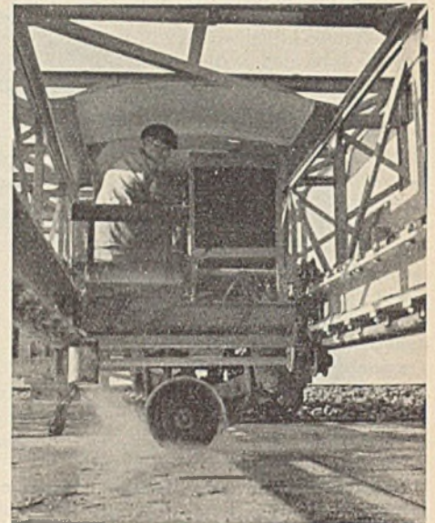
Abb. 20. Sägen von Fugeneinschnitten im erhärteten Beton.
