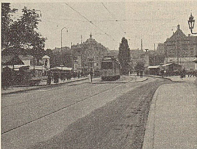
Abb. 14. Straße auf der Ludwigsbrücke — alter Zustand. Die Fahrbahnen beiderseits der Straßenbahninseln sind nur einspurig.
