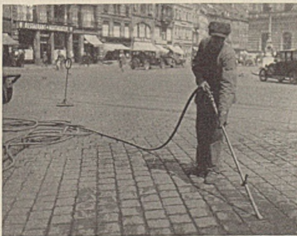
Abb. 4. Reinigung der Pflasterfugen mit Preßluft.
