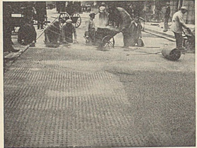
Abb. 8. Einbau von Gußasphalt.
