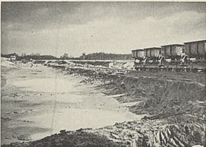
Abb. 9. Der tiefe Entwässerungsschlitz.
