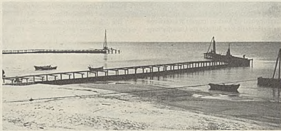
Abb. 3. Buhnenbau Koserow. Buhnen 34 und 34a im Bau.
