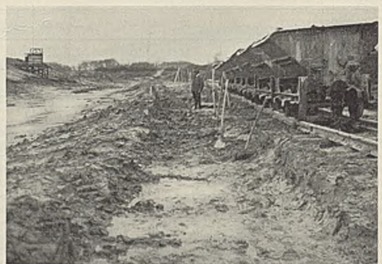
Abb. 8. Handschacht bis NN + 54,50 mit leichtem Gerät.
