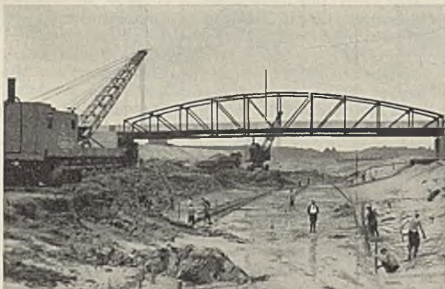
Abb. 10. Aushub im Baggerbetrieb.
