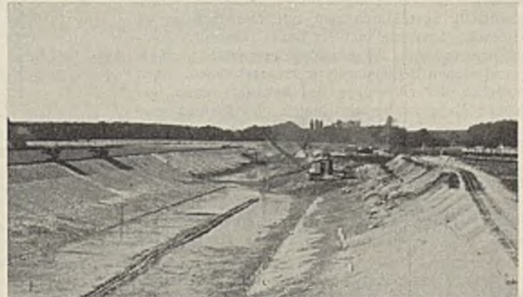
Abb. 12. Die fertige 2. Fahrt unterhalb der Brücke.
