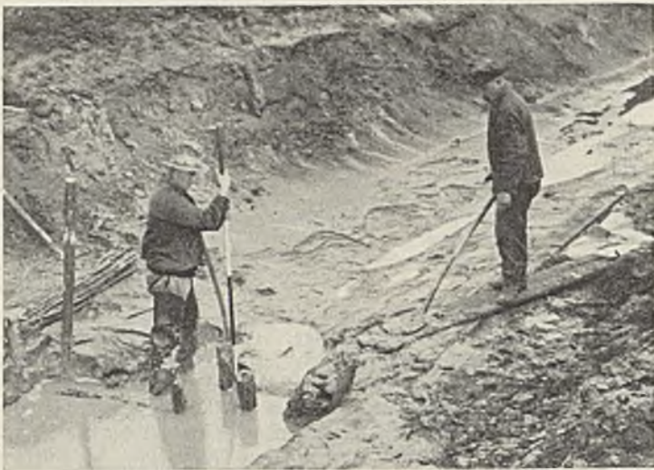
Abb. 5. Verschlammung der Sohle des linksseitigen Kanalseitengrabens.
