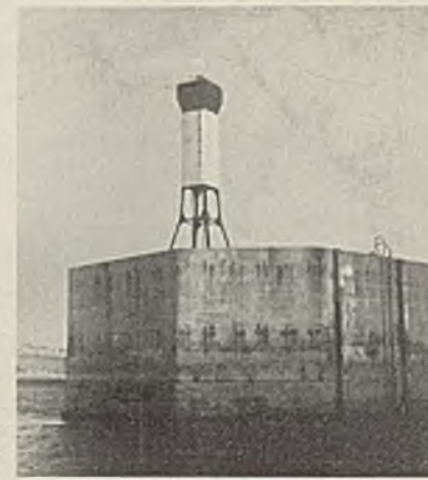
Abb. 9. Luftnebelsignal Helgoland-Süd (Senderturm).
