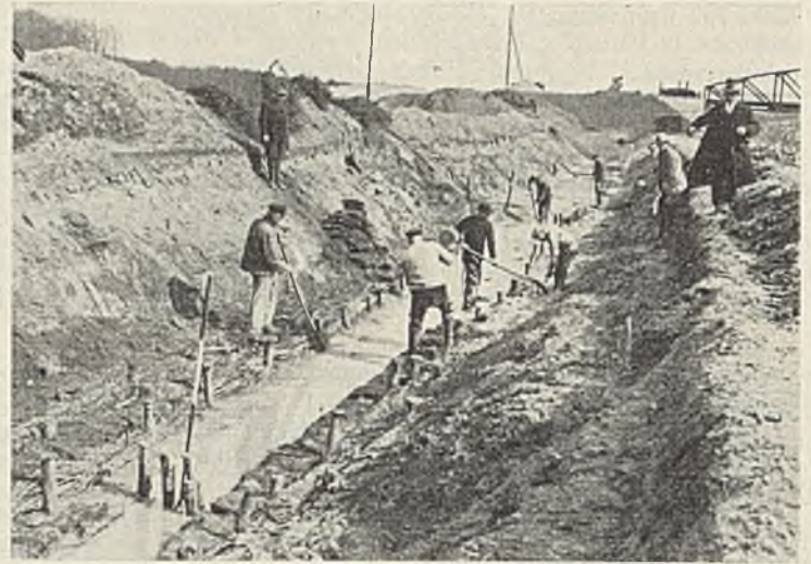
Abb. 6. Ausbau des linksseitigen Kanalseitengrabens.
