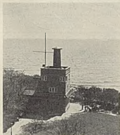
Abb. 8. Luftnebelsignal Staberhuk auf Fehmarn. Maschinenhaus mit Senderturm.
