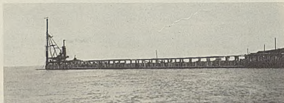
Abb. 4. Verlängerung der Ostmole Dievenow. Bauvorgang bei 78 m Länge.
