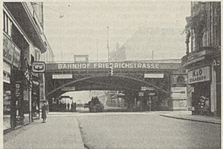
Abb. 18. Unterführung der Friedrichstraße. Alte Überbauten.
