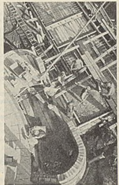
Abb. 12. Aufmauern des Bedienungsturmes. Betonieren des Rohrkanals. 30. Oktober 1936.
