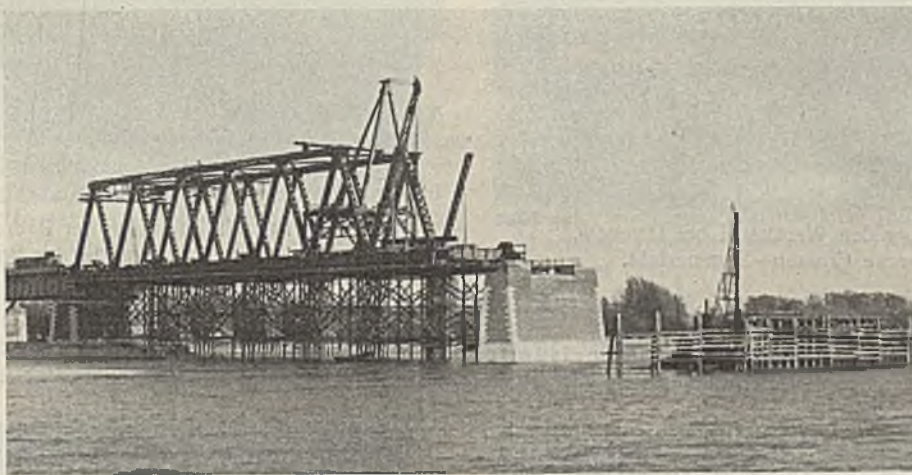
Abb. 9. Rheinbrücke bei Speyer. Stromüberbau im Bau.
