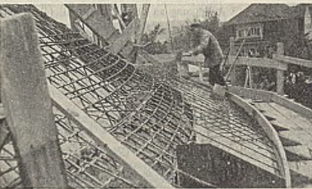
Abb. 11. Betonieren des Hauptsimses. 13. Oktober 1936.
