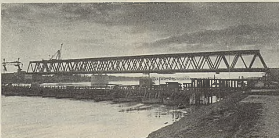
Abb. 10. Rheinbrücke bei Maxau. Blick auf die Brücke vom linken Ufer aus.
