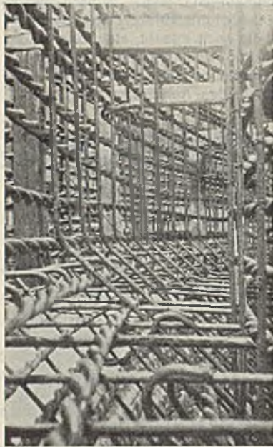
Abb. 6. Isteg-Ringbewehrung des Zugringes zwischen senkrechter Wand und unterem Kegel. 23. September 1936.
