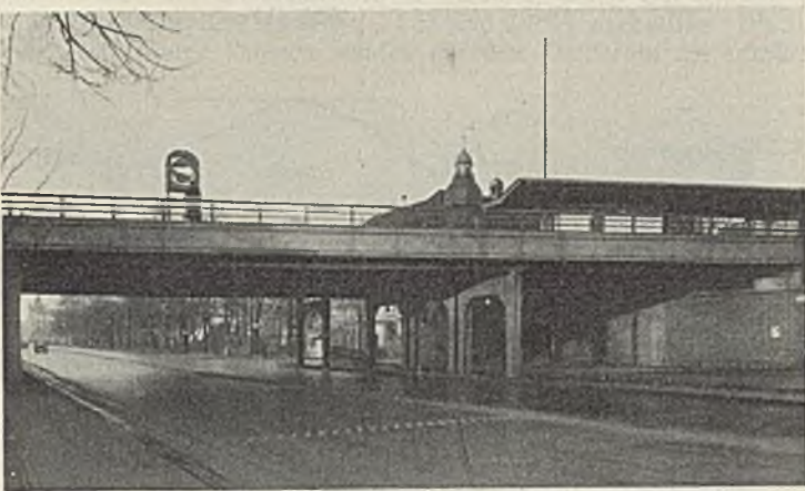
Abb. 17. Unterführung der Charlottenburger Chaussee.
