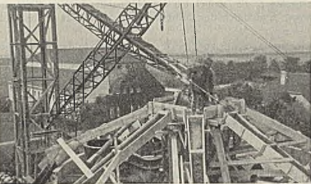
Abb. 10. Betonverteilungstisch mit Schüttrinnen beim Betonieren der senkrechten Wände und des oberen Kegels. 13. Oktober 1936.
