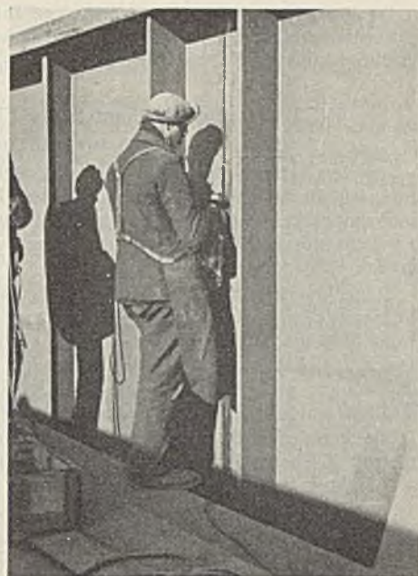
Abb. 10. Schleifen der Stegblechstumpfstoße der festen Überbauten der Eisenbahnbrücke.
