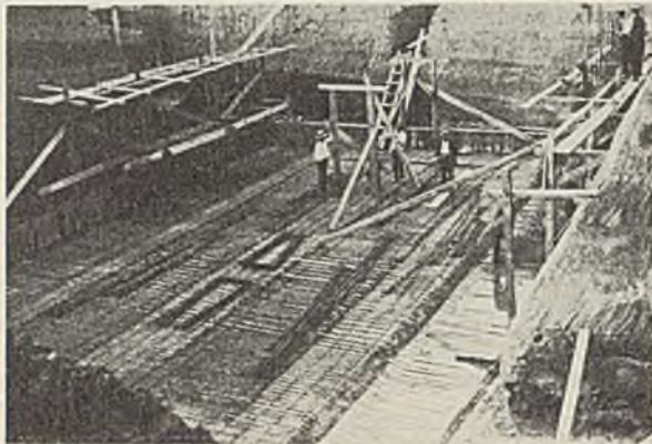
Abb. 4. Plattenfundierung bei Vrtic.
