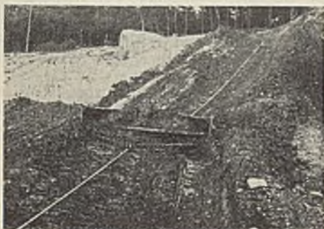
Abb. 2. Schrapper beim Planieren. Werkphoto: Hasenclever.
