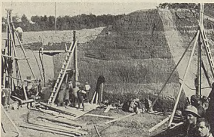
Abb. 6. Dammeschnitt und Rammen der Spundwände bei Vrtic.
