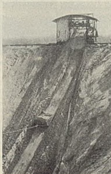
Abb. 4. Schiefe Ebene einer fahrbaren Sandförderanlage. Werkphoto: Emil Wolff.
