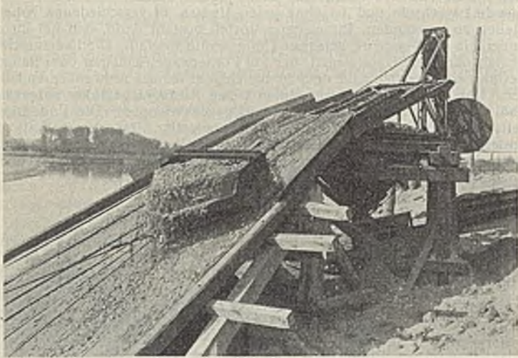
Abb. 1. Verladebrücke mit Entladestelle. Werkphoto: Bleichert.
