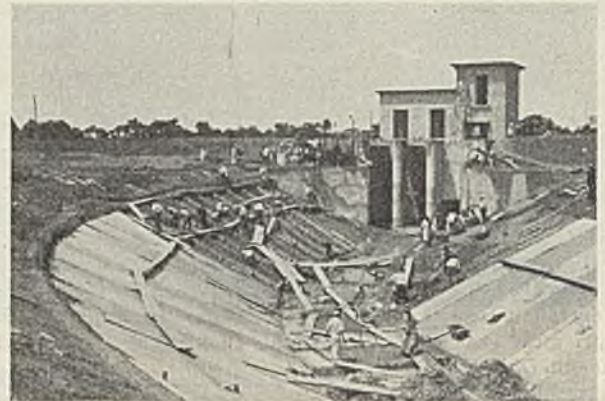
Abb. 9. Druckkanalausbildung bei Vrtic.
