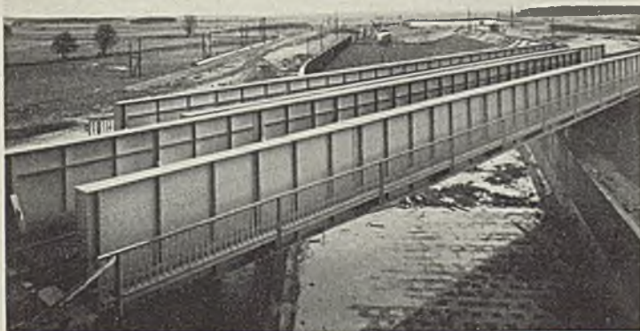
Abb. 20. Kanalschleusenbrücke in km 189,4 der Strecke Lehrte—Oebisfelde.
