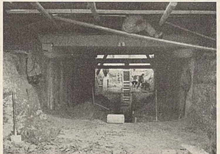
Abb. 5. Die freigelegte fertige Tragkonstruktion.
