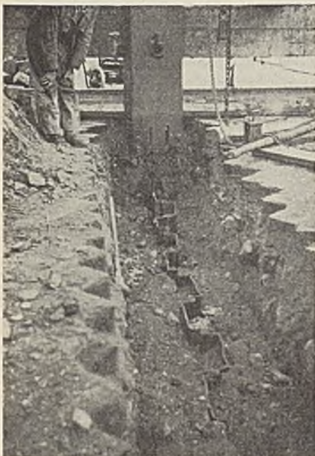
Abb. 2. In einer Nachtschicht abgerammte Larssen-Spundwandbohlen, die die zukünftigen Seitenwände der Unterführungen bilden.
