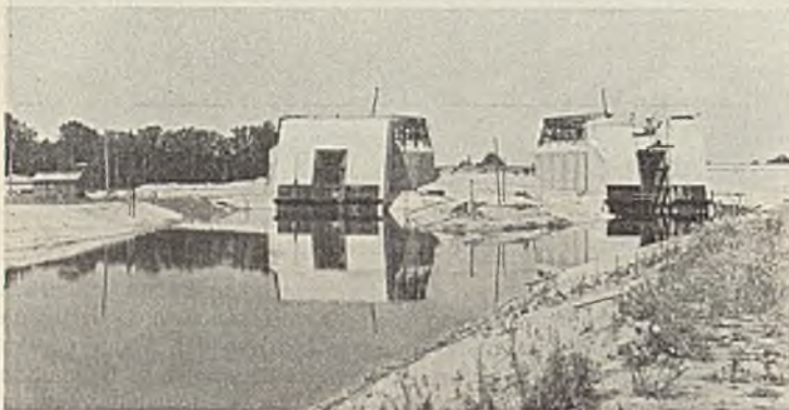
Abb. 27. Staubecken Turawa. Entlastungsbauwerk von der Beckenseite.
