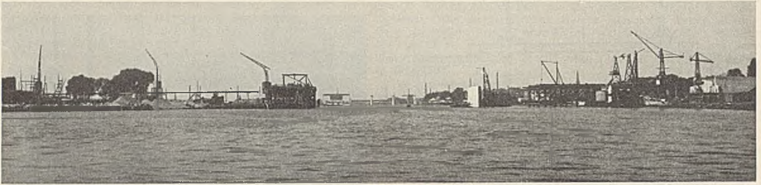
Abb. 26. Überblick über die Baustelle im August 1934.
