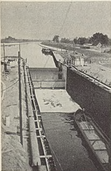
Abb. 24. Schleuse V (Stauwerder). Füllen der Südkammer.
