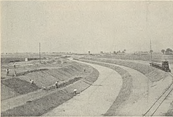
Abb. 6. Doppelquerschnitt des Isen-Flutkanals bei Odmühle (Kulturbauamt Mühldorf).
