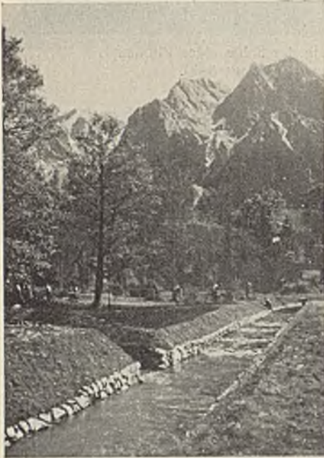
Abb. 12. Steinrollierung der Sohle und des Böschungsfußes des Krepbaches (Kulturbauamt Weilheim).
