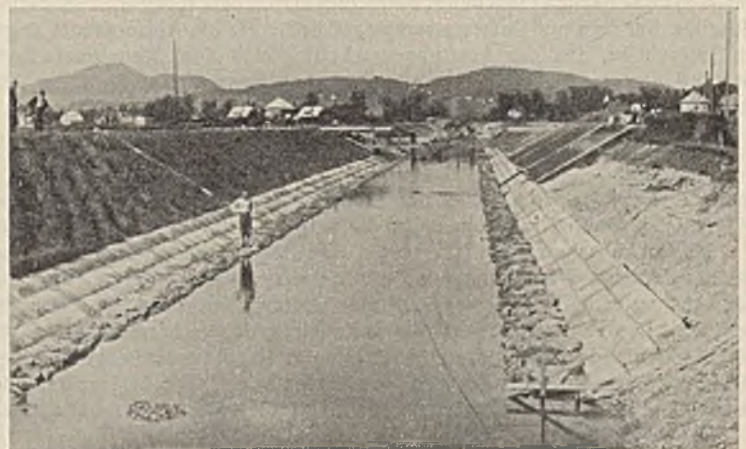
Abb. 20. Befestigung des Böschungfußes eines Durchstiches der Glan mit Betonplatten und einem Steinwurf (Landesbauamt Salzburg).
