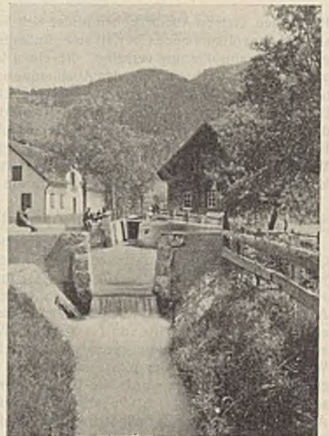
Abb. 38. Absturzbauwerke im Mühlebach Nüziders (Forsttechnische Abteilung für Wildbachverbauung, Sektion Bregenz).
