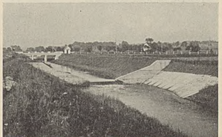
Abb. 40. Absturzbauwerk in der Rott bei Raisting (Doppelquerschnitt) (Kulturbauamt Weillheim).
