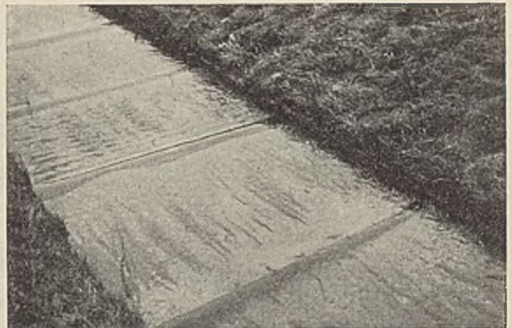
Abb. 11. Ausriegelung eines Baches, Riegel auf einen Faschinenteppich verlegt (Kulturbauamt Ingolstadt).
