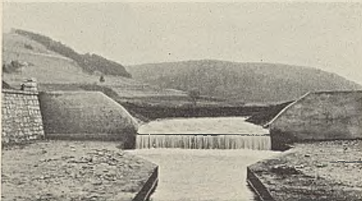
Abb. 41. Unterteilter Absturzquerschnitt eines Bauwerks in der Sulz in Beilngries (Beginn der Ortsregelung) (Kulturbauamt Regensburg).
