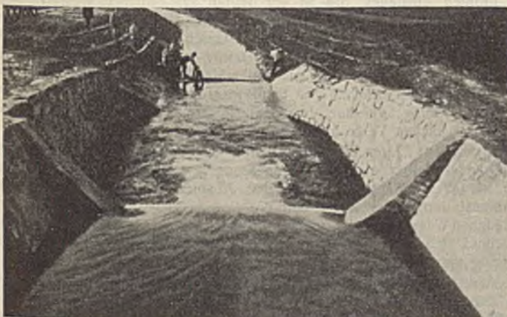
Abb. 39. Ausbildung des Absturzquerschnitts eines Bauwerks im Kollbachgraben (Kulturbauamt Deggendorf).
