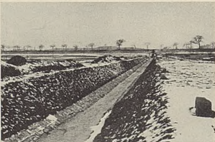
Abb. 13. Trockenpflaster der Sohle und des Böschungsfußes in der Schwarzach (Kulturbauamt Regensburg).
