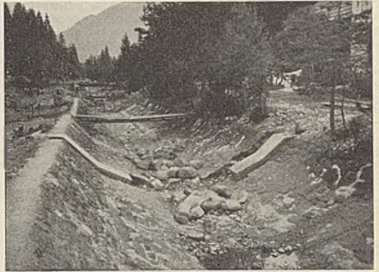
Abb. 18. Derselbe, Einbau schwerer Betonrippen (Böschung- und Sohlenbefestigung) bei den Wiederherstellungsarbeiten.
