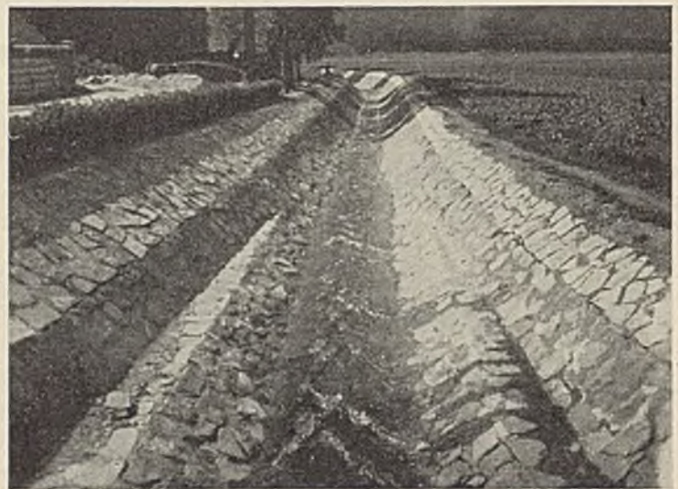
Abb. 16. Hammermühlbach-Flutkanal nach der Wiederherstellung, Erweiterung des Bachquerschnitts unter einer Straßenbrücke.
