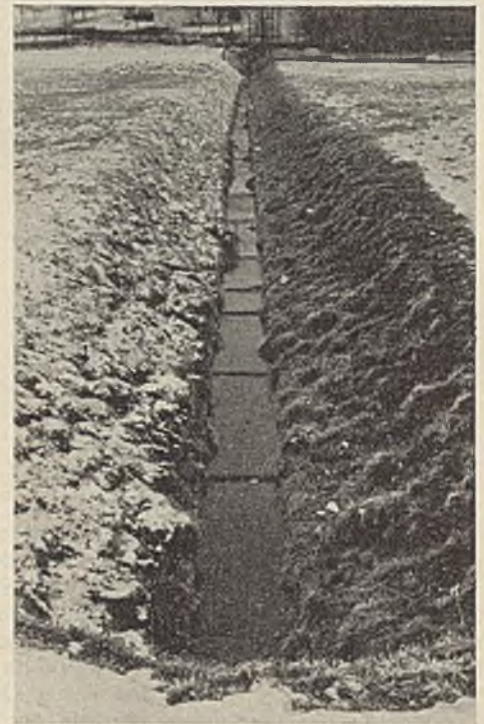
Abb. 10. Ausriegelung eines Baches (Kulturbauamt Weilheim).
