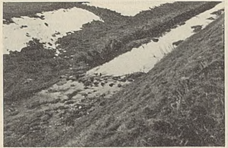
Abb. 9. Verpfählung der Sohle eines Flutkanals (Kulturbauamt Donauwörth).
