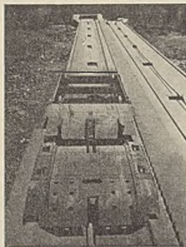
Abb. 123. Odertalsperre. Blick auf die Rollbahn vom Windenhaus.
