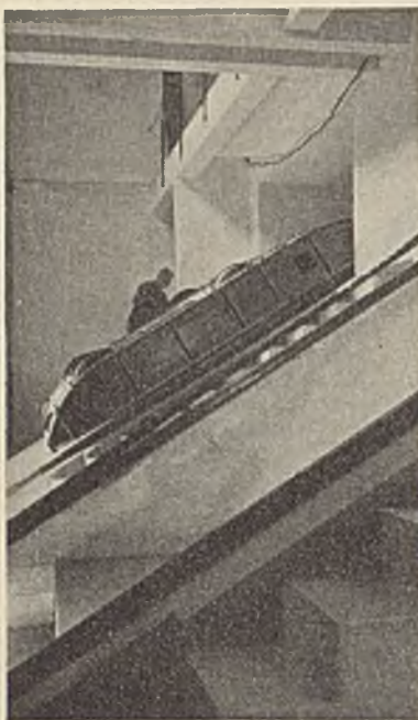
Abb. 122. Odertalsperre. Inneres des Windenhauses für die Schützenverschlüsse der Grundablaßeinläufe.
