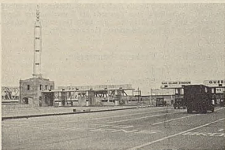
Abb. 14. Brückenzoll-Abfertigungsstelle auf dem Verkehrssammelplatz der Triborough-Brücke, im Vordergrund die Streifen-einteilung der Fahrbahn, über den Kassenhäuschen die Richtungstransparente, links neben dem Beleuchtungsturm die Fachwerkbrücke nach Bronx.
