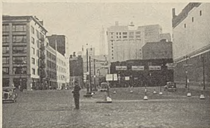
Abb. 21. Verkehrsverteilungsplatz mit Transparenten an der Ostausfahrt des Holland-Tunnels.
