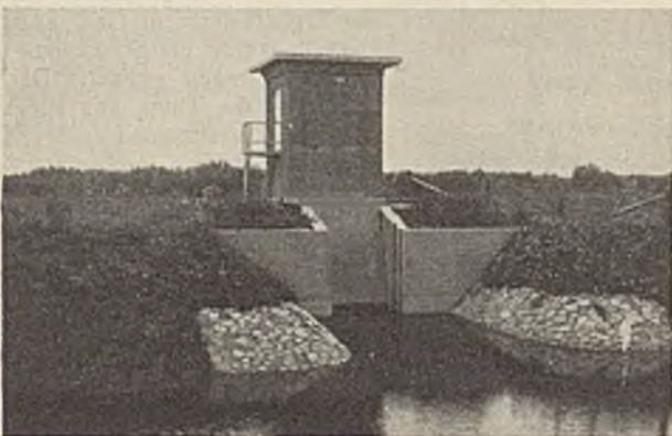
Abb. 10. Schöpfwerk Platen. Einlaufseite.
