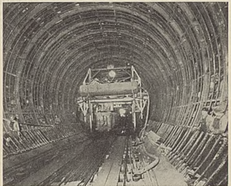
Abb. 7. Blick in einen fertig ausgebrochenen und mit Eisen auszimmertern Stollen, zwischen den Ringen Bewehrungseisen.
