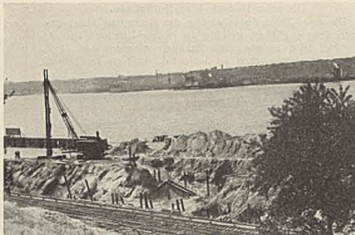
Abb. 36. Neue Hudson-Ufer-Hochstraße. Gründungsarbeiten für die Eintunnelung der Eisenbahn.
