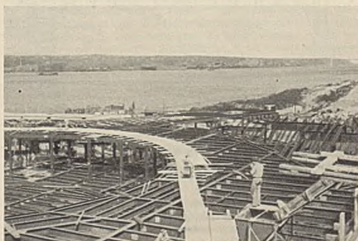
Abb. 39. Neue Hudson-Ufer-Hochstraße. Dreistöckiger Rundbau als Stahlkonstruktion im Bau.
