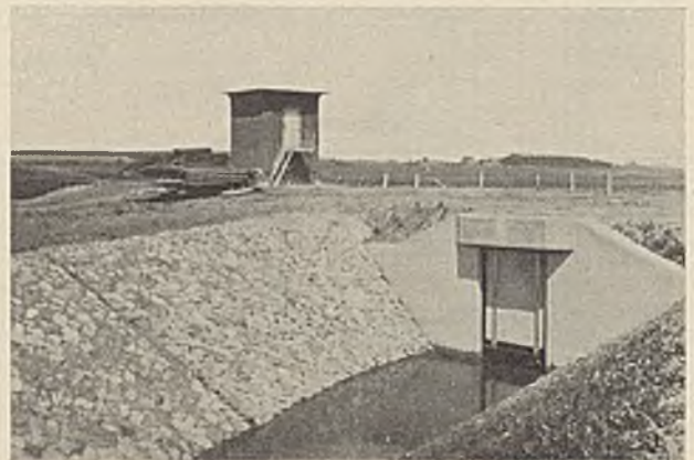
Abb. 11. Schöpfwerk Platen. Freiauslaß.
