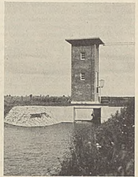
Abb. 13. Schöpfwerk Kuhlfließ. Auslauf zum Pregel.
