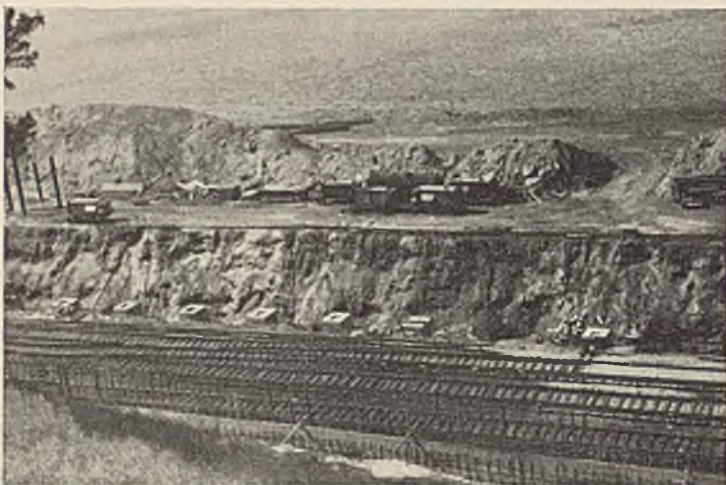
Abb. 37. Neue Hudson-Ufer-Hochstraße. Gründungsarbeiten für die Eintunnelung der Eisenbahn.
