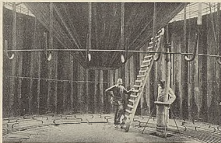
Abb. 32. Bergschädenbewehrung des Fundamentes.
