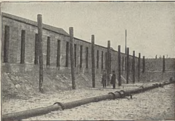
Abb. 21. Stützmauer an der Zulaufseite mit Pressungsfuge.
