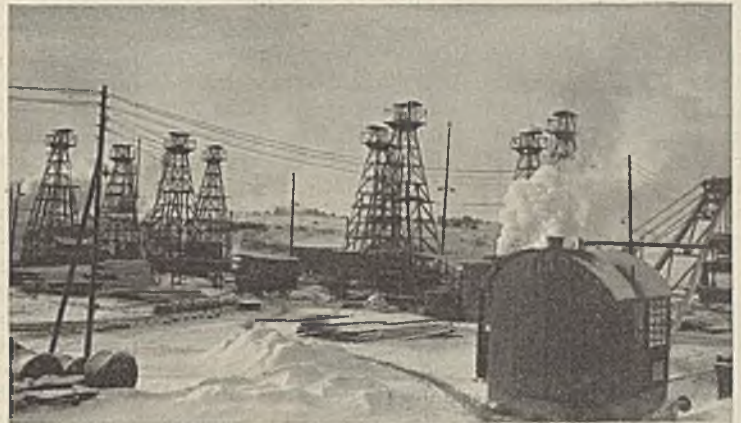
Abb. 48. Schiffshebewerk Hohenwarte. Bohrtürme für das Einsetzen der Gefrierrohre.
