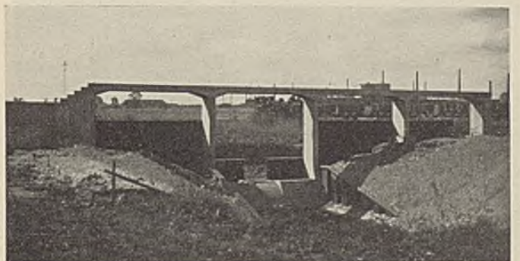
Abb. 52. Umgehungskanal bei Merseburg. Abzweigbauwerk für die „Alte Saale“.
