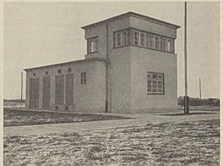
Abb. 61. Bedienungshaus für die beiden Schleusen Dörverden.
