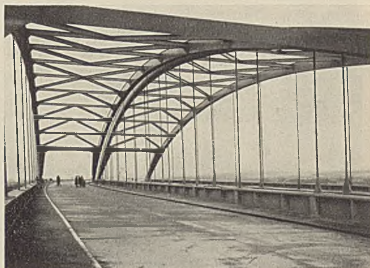
Abb. 2. Kaiserbergbrücke bei Duisburg. Blick in die Brücke.
