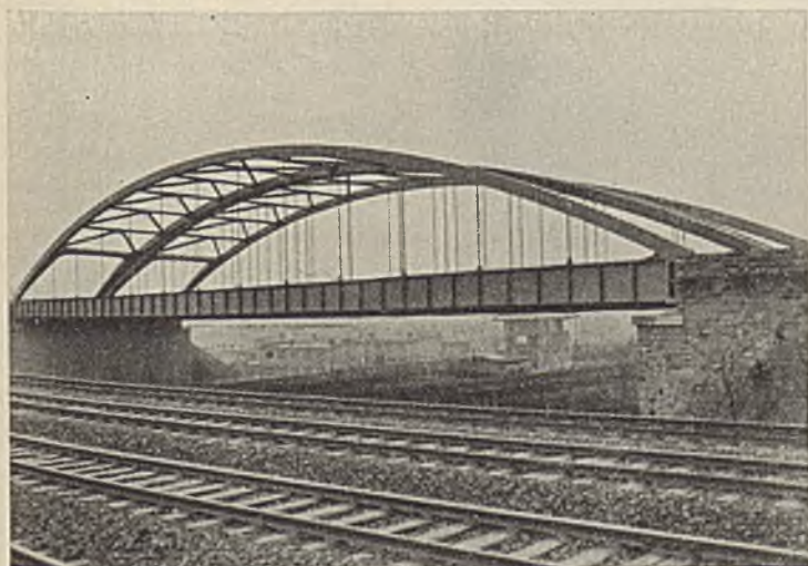
Abb. 1. Kaiserbergbrücke bei Duisburg. Ansicht.
