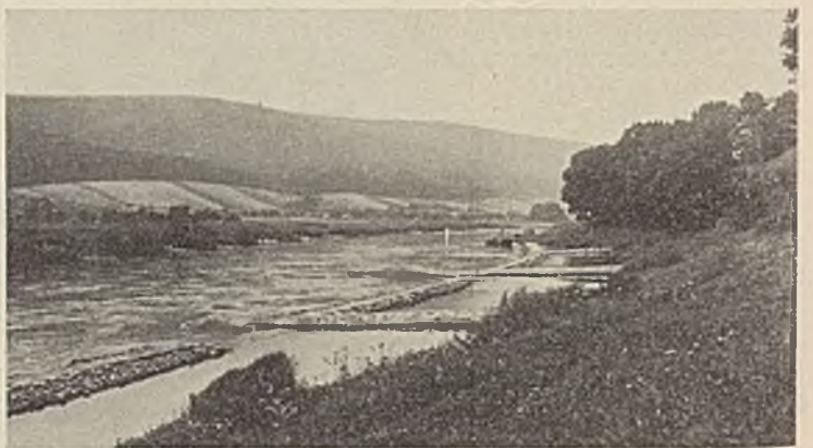
Abb. 57. Niedrigwasserregulierung der Weser bei Weiße Hütte.
