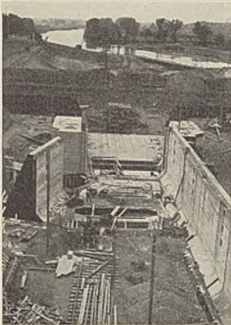
Abb. 54. Saaleschleuse Rothenburg. Blick in die Schleusenammer vom Oberhaupt.
