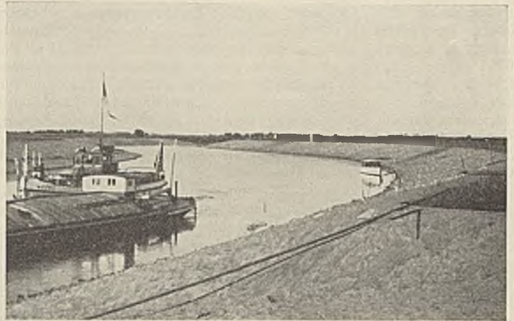
Abb. 59. Umbau der Allermündung. Die fertige Mündungsstrecke.
