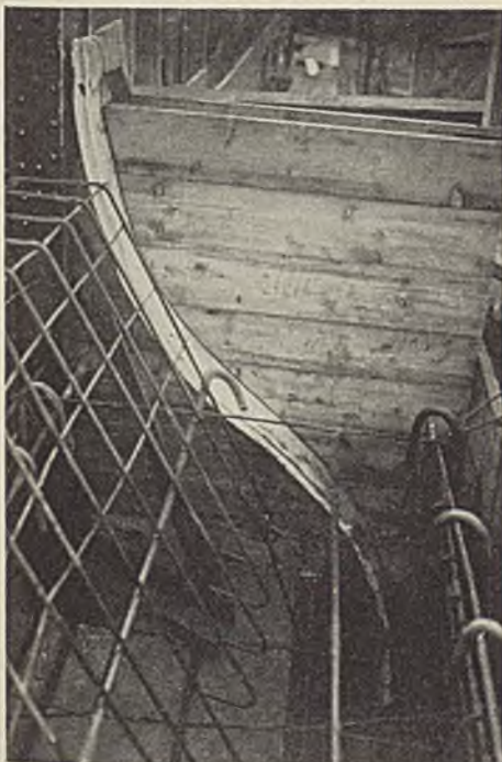
Abb. 23. Bleibitumenplatte zur Überbrückung der Pressungsfugen.
