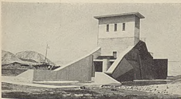
Abb. 51. Elster-Saale-Kanal. Entlastungsanlage im Zschampertdamm.
