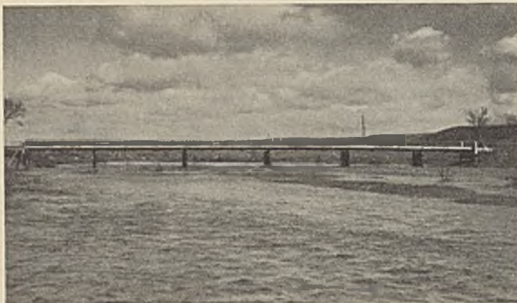
Abb. 56. Ederbrücke bei Anraff.
