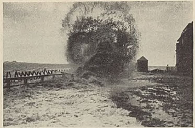
Abb. 7. Brecher an der Bohlwand des Nordstrandes bei Sturmflut (Nordwest Stärke 11). Rechts die Biologische Anstalt.
