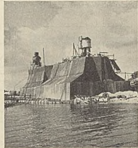
Abb. 9. Senkkasten für die Bremspfeiler auf dem aufgespülten Dammbau.
