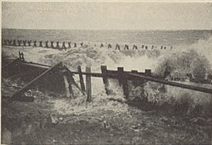
Abb. 6. Sturmbrandung am Palisadenwerk. Im Vordergrunde beschädigte Bohlwand.
