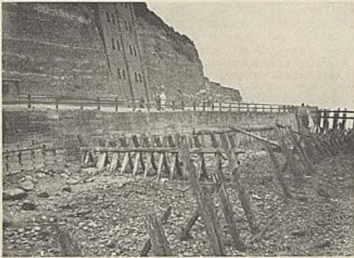
Abb. 4.) Alte Bohlwand am Nordstrand. Davor Reste des ersten Palisadenwerks von 1862.
