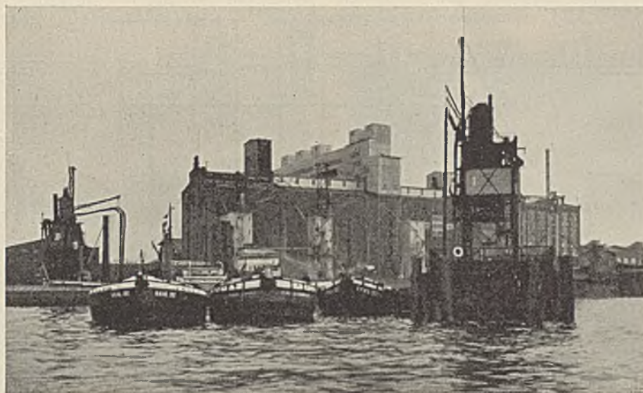
Abb. 1. Gesamtbild der Anlage von der Wasserseite.
