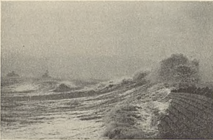
Abb. 8. Brecher über dem geneigten Bohlwerk am Kurhause bei Sturmflut (Nordwest Stärke 11).
