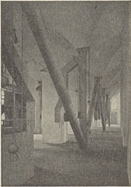
Abb. 5. Raum unter den Silos.
