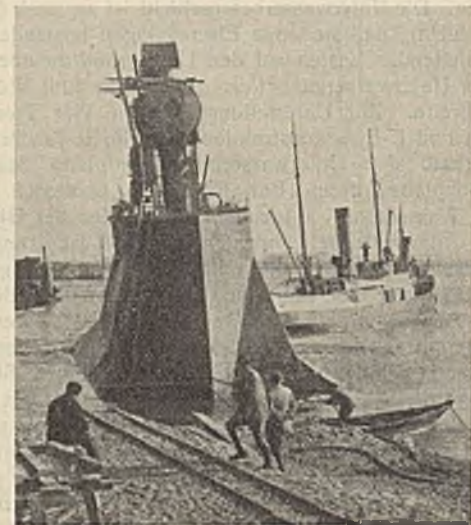
Abb. 10. Abschleppen eines Senkkastens der Bremspfeiler.
