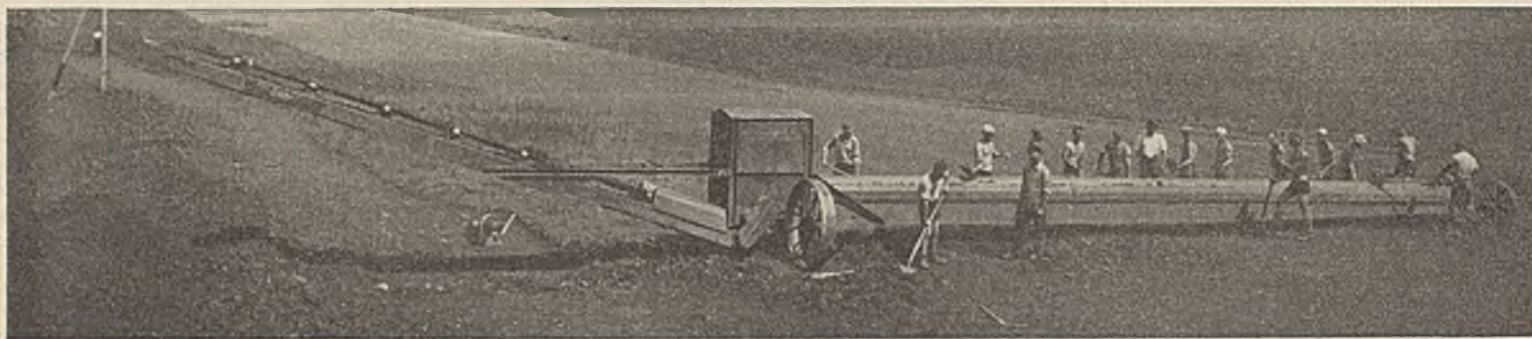
Fahrbares Förderband mit einem waagerechten und einem schrägen Teil. Bauart Wilh. Stöhr.
