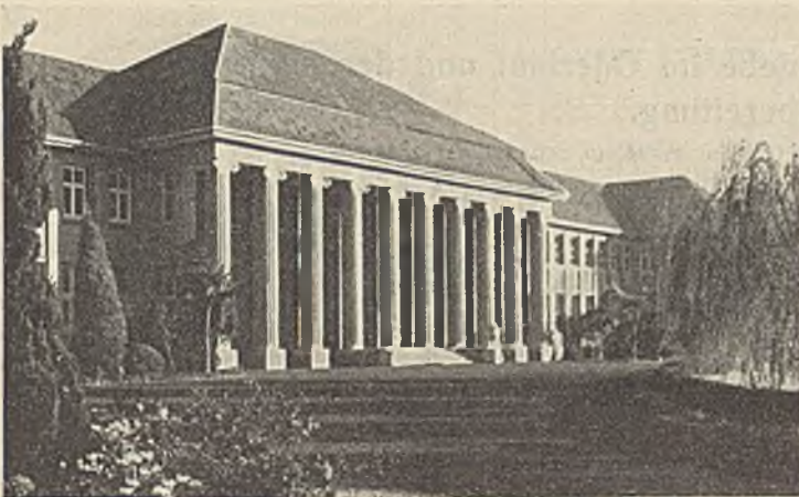
Abb. 1. Hauptgebäude der Universität.
