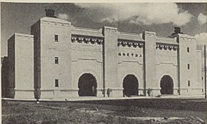
Abb. 3. Der Eingang zum Stadion.
