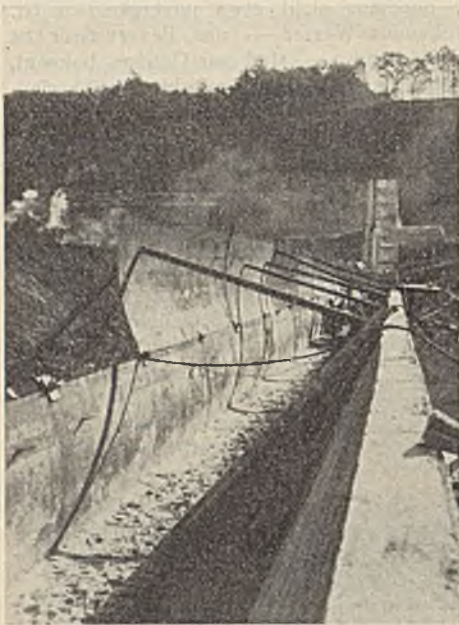
Abb. 2. Aufbau der Stahldichtungswand.
