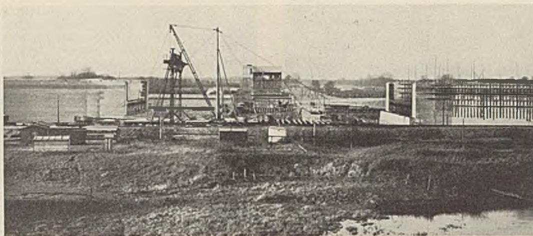
Abb. 73. 2. Fahrt an der Ems. Widerlager und Mittelpfeiler der Kanalbrücke.
