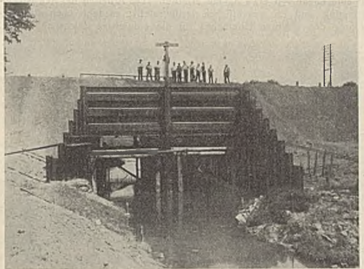
Abb. 72. 2. Fahrt bei Hilstrup. Behelfmäßige Unterführung des Emmerbaches.
