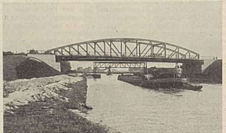
Abb. 67. Deusener Brücke, dahinter altes Sicherheitstor.
