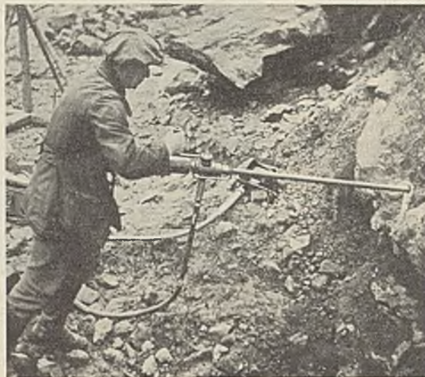
Elektrohammer mit Zusatzeinrichtung zum Entfernen des Bohrmehls beim Bohren eines Sprengloches, Bauweise Robert Bosch AG.
