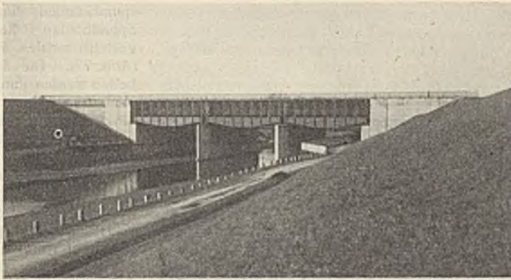
Abb. 68. 2. Fahrt bei Olfen. Kanalbrücke über die Lippe.
