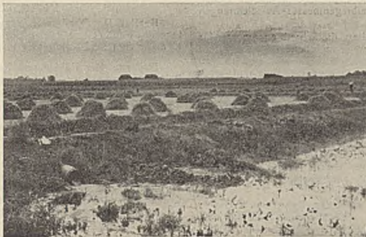
Abb. 4. Rieselfelder Werne a. d. Lippe. Überstauen einer Fläche nach Abschluß der Dränung.
