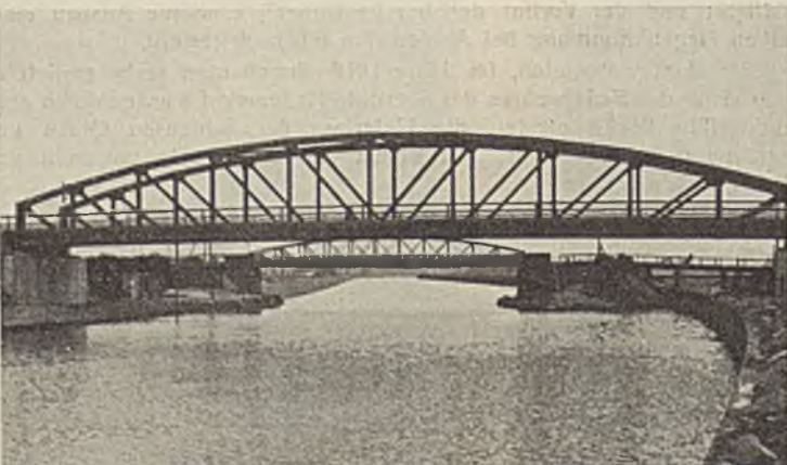
Abb. 66. Neue und alte Schwieringhauser Brücke.
