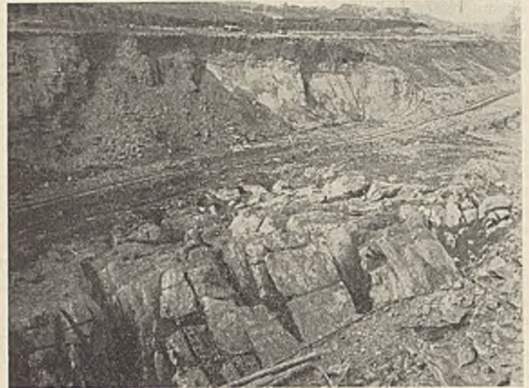
Abb. 7. Freigelegte zerklüftete Kalkschichten im Dammlager.
