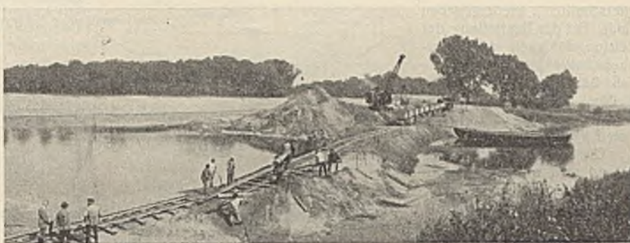
Abb. 18. Durchstich an der Saalemündung beim Saathorn und Bau des Trennungsdammes am oberen Ende des Durchstiches.
