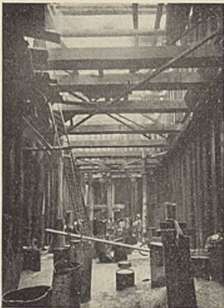
Abb. 13. Leergepumpte Baugrube des Pfeilers 9.
