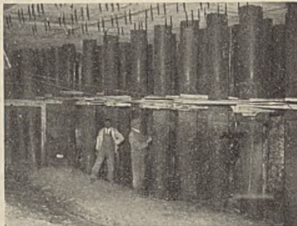
Abb. 16. Isolieren der Pfähle unter Widerlager B.
