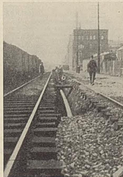
Abb. 1. Entwässerung des Zwischenraumes der Gleise durch Rohre in der Längsrichtung.
