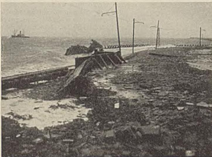
Abb. 15. Das Bohlwerk im Augenblick des Bruches am 26. November. Das zerstörte Stück wird seewärts herausgerissen. Im vorderen Ende des Bohlwerks Durchlaß mit Schott für ein Baugleis.
