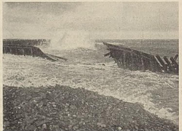
Abb. 16. Das Bohlwerk nach dem Bruch.
