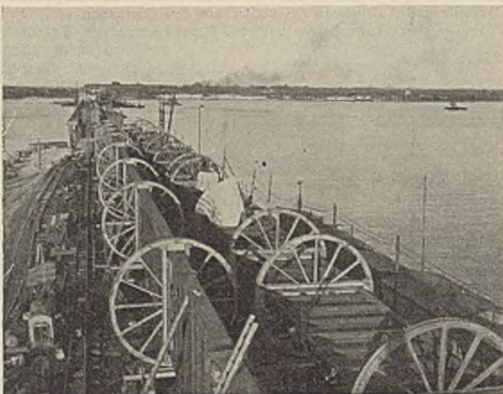
Abb. 31. Eisenbahnbrücke auf dem Damm in Wälzringen.
