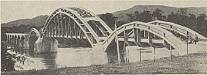
Abb. 1. Jaguaray-Brücke. Mittellöffnung 60 m, zwei Seitenöffnungen je 30 m.
