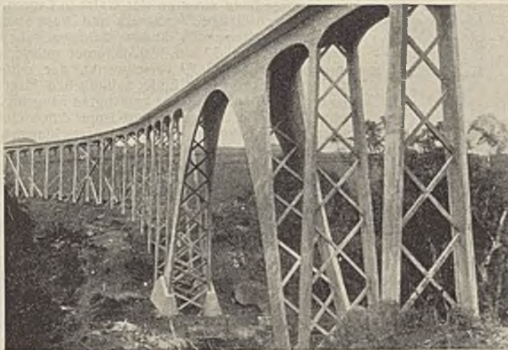
Abb. 3. Franklin-Brücke. Mittellöffnung 40 m, 19 Seitenöffnungen je 8 m, Höhe 28,5 m.
