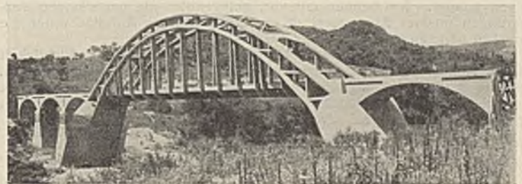
Abb. 2. Rosario-Brücke. Hauptöffnung 60 m, vier Nebenöffnungen je 15 m.
