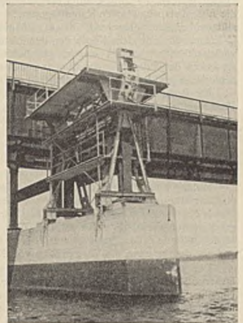
Abb. 34. Festlegung der Pendelstützen.
