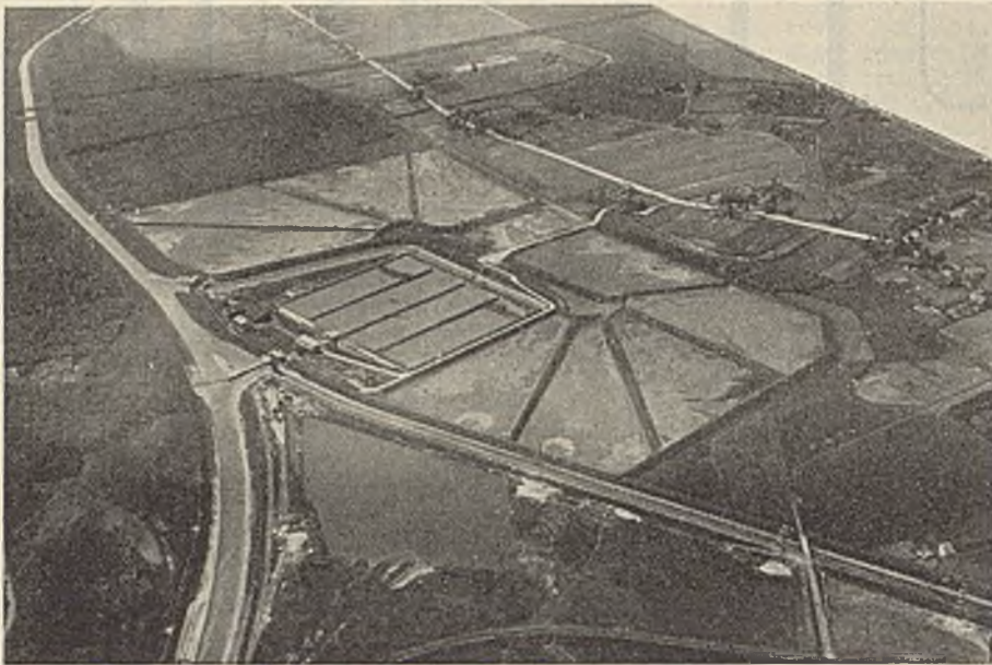
Abb. 2. Luftbild der Emscherflußkläranlage in Essen-Karnap.
