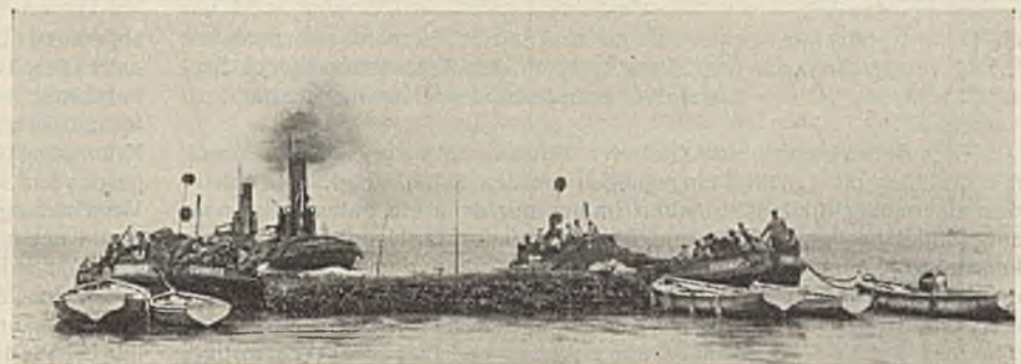
Abb. 16. Das Senkstück auf dem Wege zur Versenkstelle. Vorán zwei Schleppdampfer. An beiden Seiten Schuten mit Schüttsteinen zum Versenken sowie Arbeitsboote.
