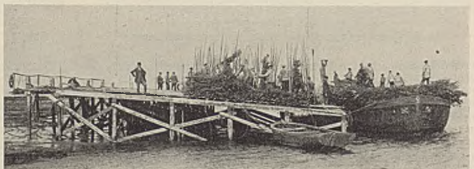
Abb. 14. Herstellung eines kleinen Senkstücks. Vor der Bank Fahrzeug mit Faschinen.
