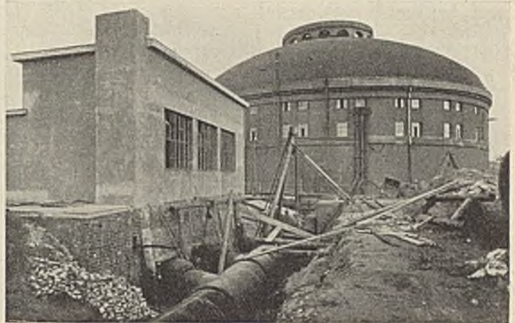
Abb. 7. Erweiterungsbau für drei Hochwasserpumpen am Pumpwerk Alte Emscher.
