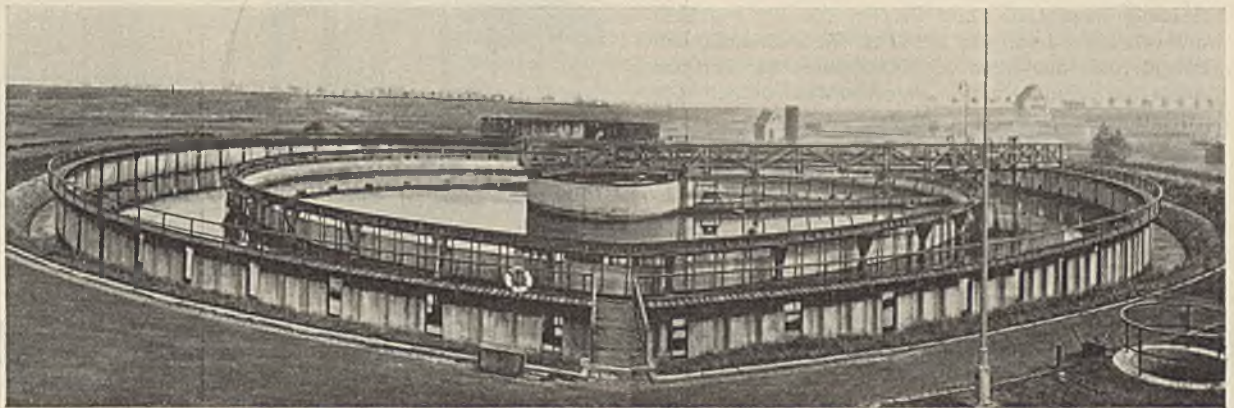
Abb. 43. Blick auf die im Betrieb befindliche Kläranlage.
