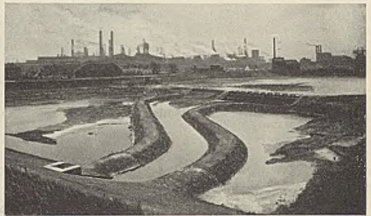
Abb. 10. Behelfmäßiger Überlauf des Auflandungsteiches am Ende der Druckrohre des Pumpwerks Alte Emscher.
