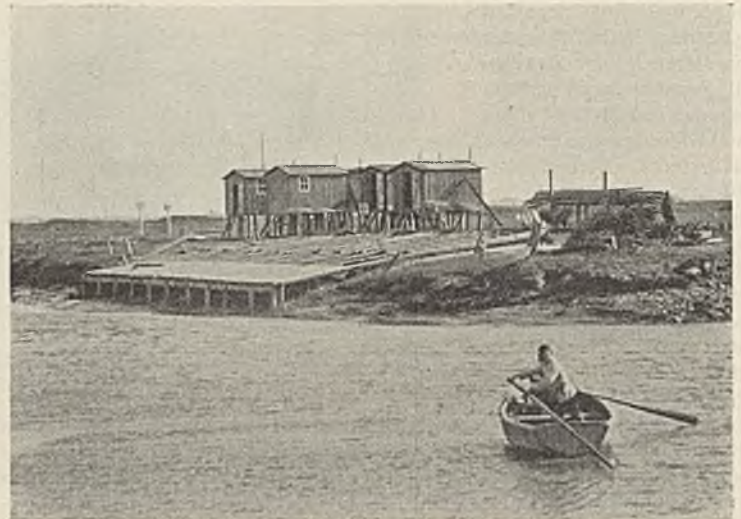
Abb. 12. Senkstückbank an hohem Ufer bei NW. Dahinter aufgeständerte Baubuden.
