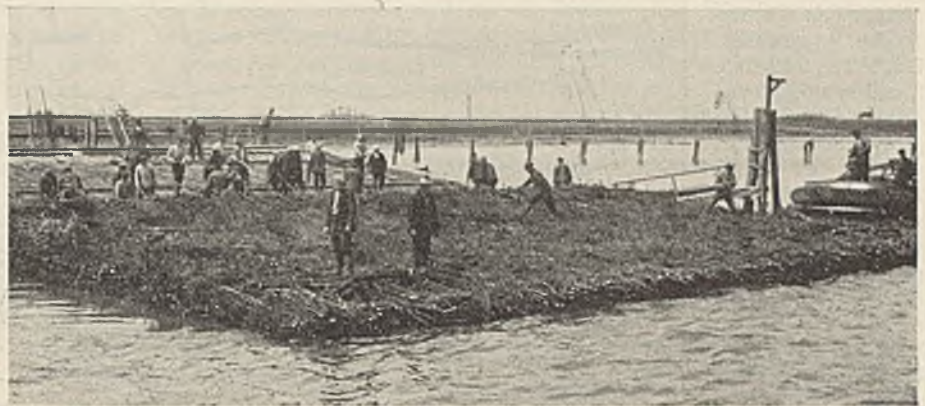
Abb. 15. Zu Wasser gelassenes Senkstück. Links hinten anschließend die Bank. Rechts das Heck des Schleppdampfers, an den die Schleppseile übergeben werden.
