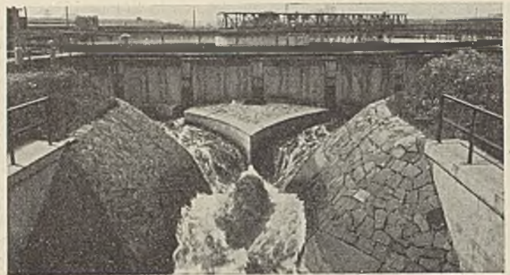
Abb. 45. Mechanisch gereinigter Ablauf der neuen Kläranlage. Ablauf aus dem einen Becken zur Zeit über 3000 l/sek.
