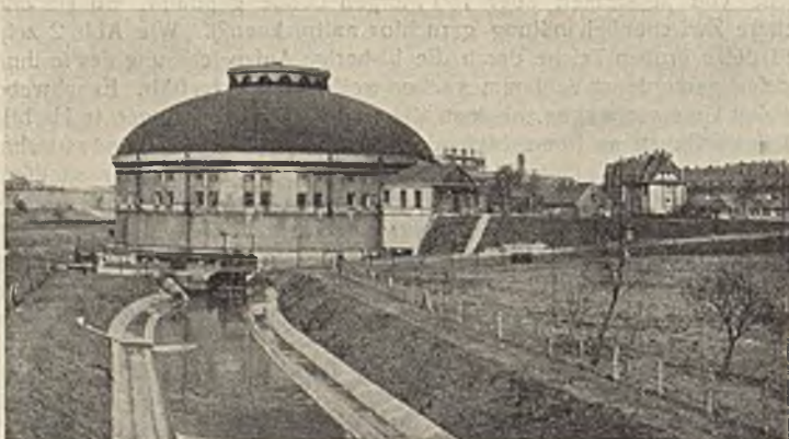
Abb. 4. Ansicht des Pumpwerks Alte Emscher im ersten Ausbau, davor die mit losen Sohlplatten im Dreieckprofil ausgebaute Alte Emscher.
