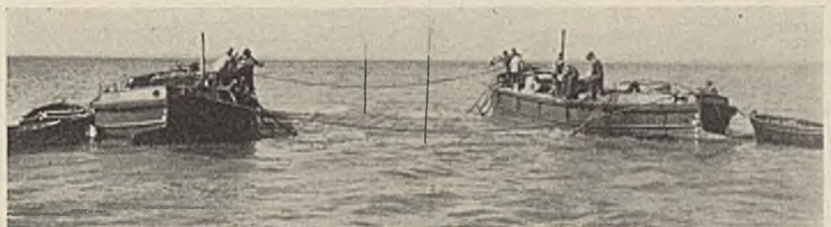
Abb. 18. Das mit Steinen beschwerte Senkstück sinkt bei Stauwasser nach Lösen der Aufhängetaue.
