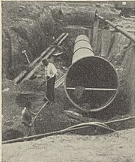
Abb. 41. Verlegung des eisernen Dükerrohres von 1,8 m Durchm. unterhalb der Beckensohle mit Grundwassersenkungsanlage. Daneben die beiden Schlammabzugrohre von 30 cm Durchm.
