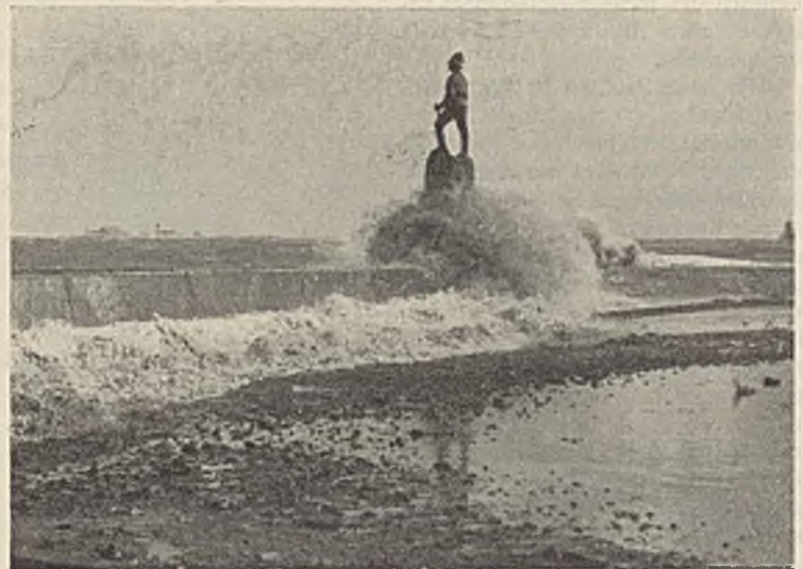
Abb. 30. Abwehrmauer des Bohlwerks nordöstlich vom Kurhause bei Sturmflut (West Stärke 10 bis 11).
