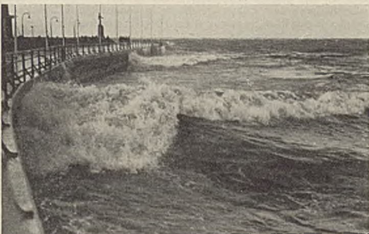
Abb. 28. Bohlwerk vor dem Kurhause bei Nordwest Stärke 6 bis 7. Wasserstand rd. 1 m unter Spundwand-OK.
