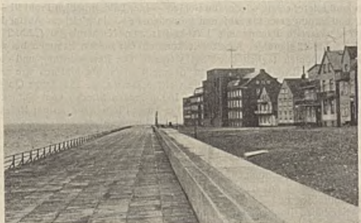
Abb. 25. Bohlwerk am Nordstrand. Abdeckung (Wandelbahn) und Abwehrmauer.
