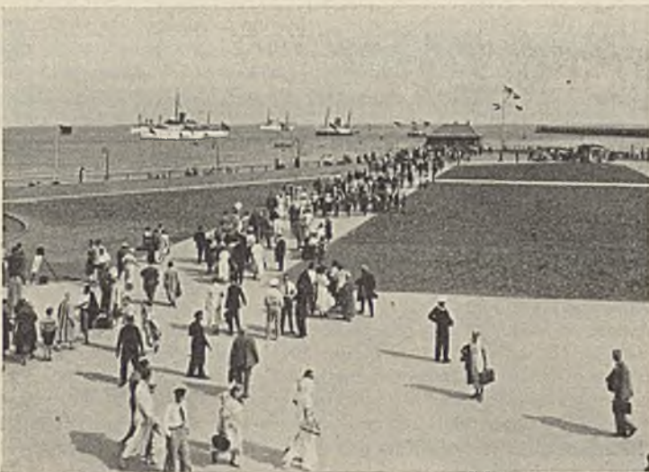
Abb. 27. Bohlwerk an der Landungsbrücke. Blick von der Kaiserstraße zum Wellenbrecher.
