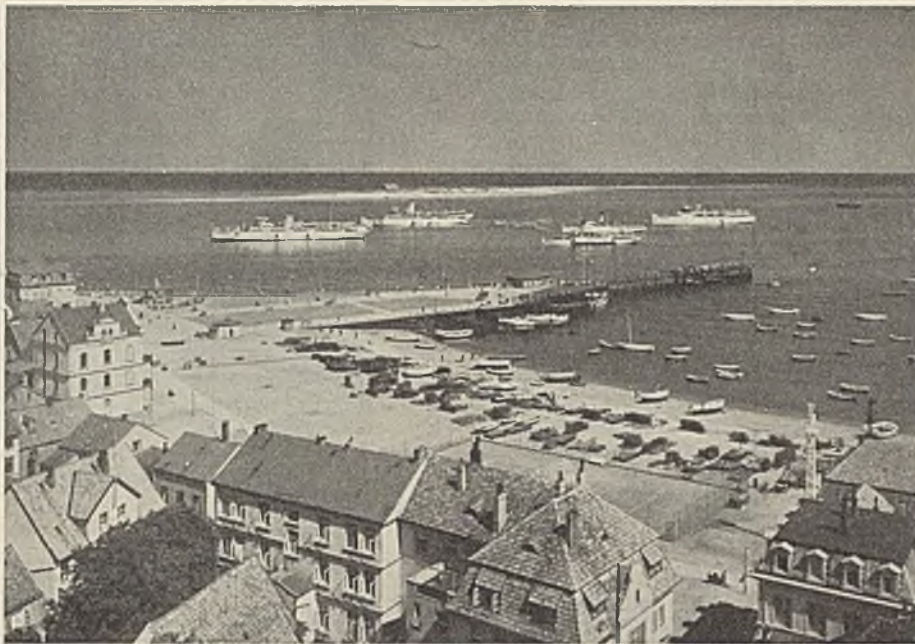
Abb. 26. Bohlwerk am Südstrand. Blick vom Oberlande.
