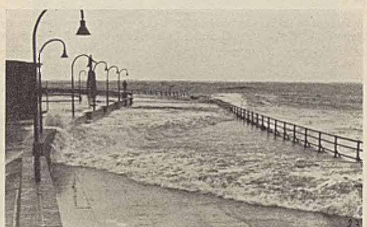
Abb. 29. Bohlwerk vor dem Kurhause bei Sturmflut (West Stärke 8 bis 10).
