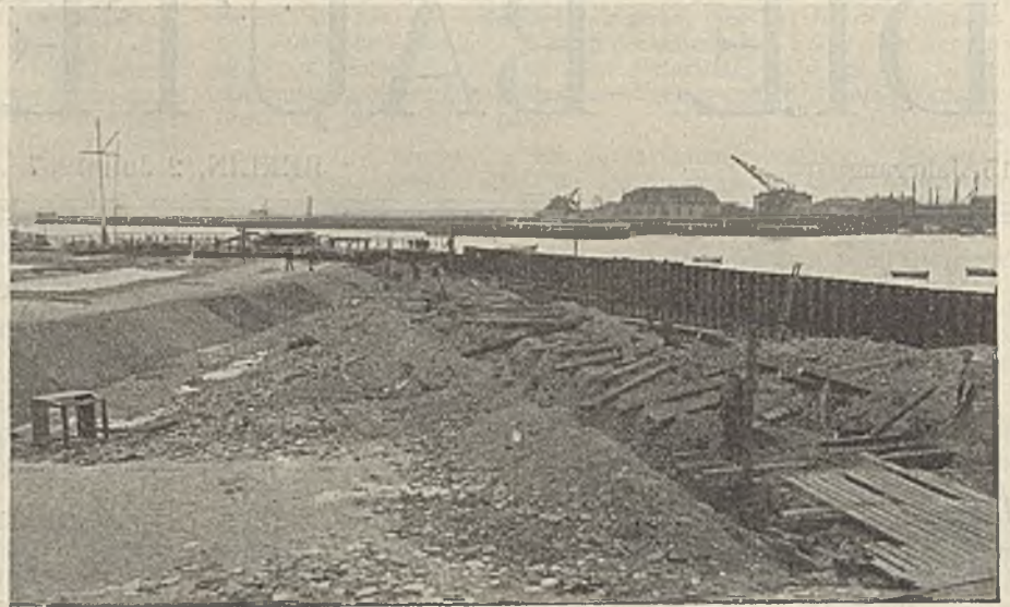
Abb. 23. Bau des Bohlwerks am Südstrand. Einbringen und Einsumpfen der Hinterfüllung.
