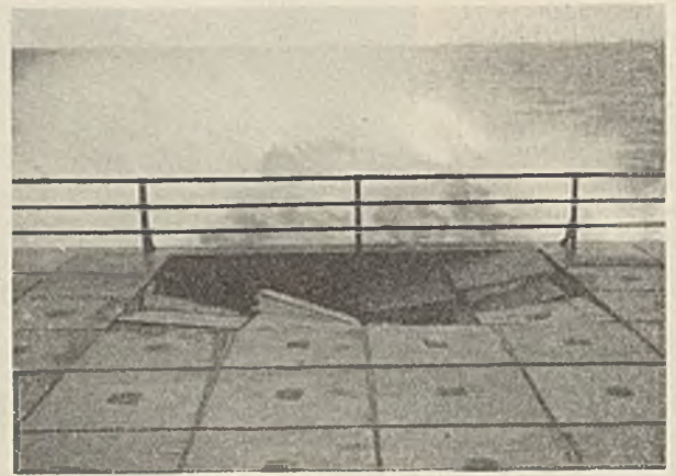
Abb. 31. Einbruch in der Betonplattenabdeckung infolge einer Undichtigkeit der Spundwand.
