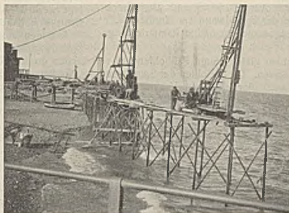
Abb. 21. Vortrieb des Rammgerüsts.
