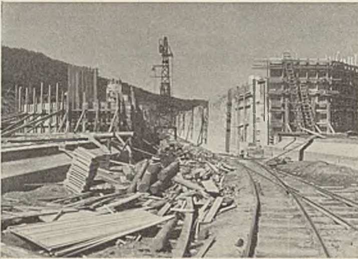
Abb. 85. Staufstufe Harrbach. Blick vom Oberhaupt in die Schleusenammer.
