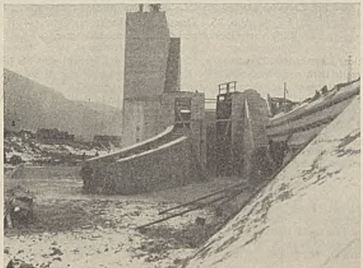
Abb. 84. Staufstufe Steinbach. Blick von unterstrom auf den Fischpaßpfeiler und Kahnschleuse.
