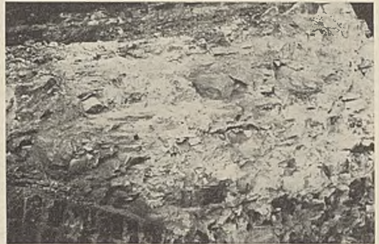
Abb. 11. Blick von Norden auf die verfestigte Zone der Ostöffnung unterhalb vw .
