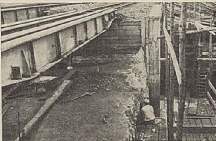
Abb. 8. Die Ostöffnung freigelegt.
