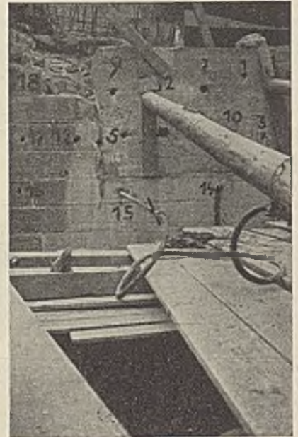
Abb. 10. Betonkörper bei P mit Steifen und Einpreßrohr.
