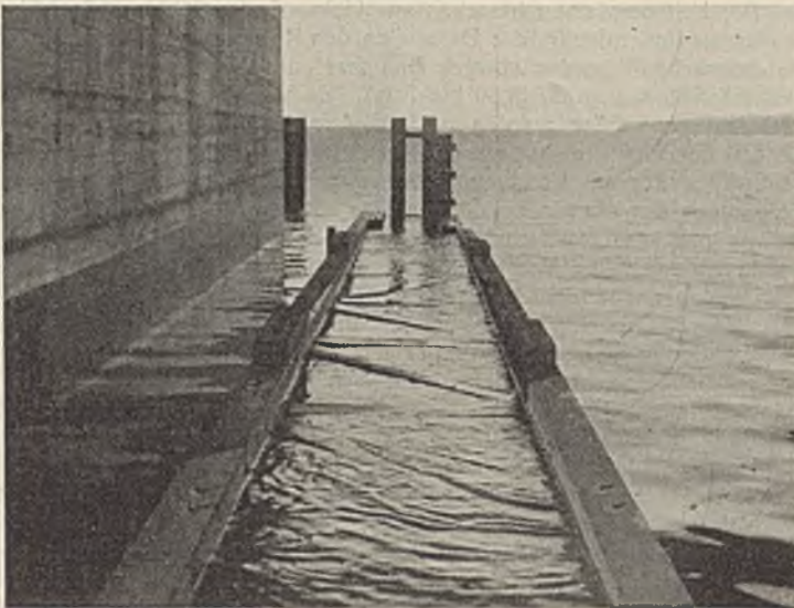
Abb. 12. Schwimmfender mit Dalben. Die Leitbohlen an den Dalben fehlen noch.
