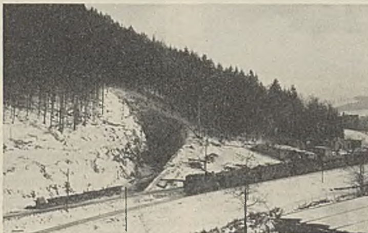
Abb. 8. Ort der Baustelleneinrichtung.
