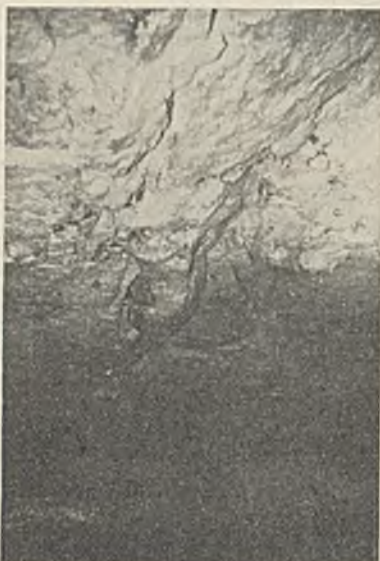
Abb. 5. Ansicht der Decke im Vollausbruch.
