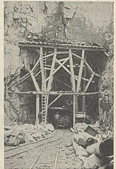
Abb. 15. Zimmerung im Vollaussbruch.
