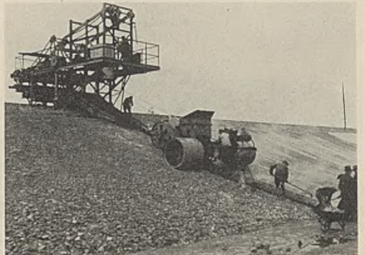
Abb. 13. Einbau der Böschungsdichtung.
