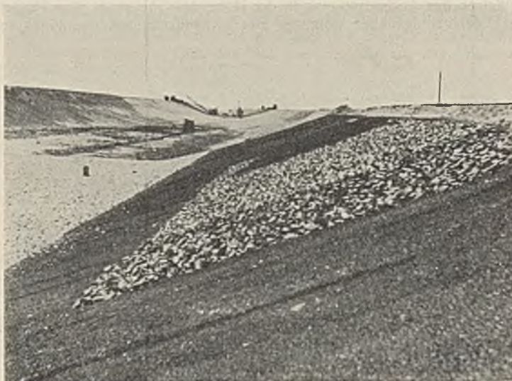
Abb. 17. Berauung der Oberfläche Schutzschicht im Bereich des Wasserspiegels.
