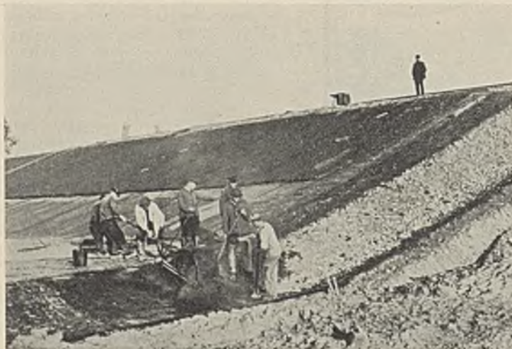
Abb. 16. Einbau der Decke in der Sohle von Hand und Übergang zur Lehm-dichtung.
