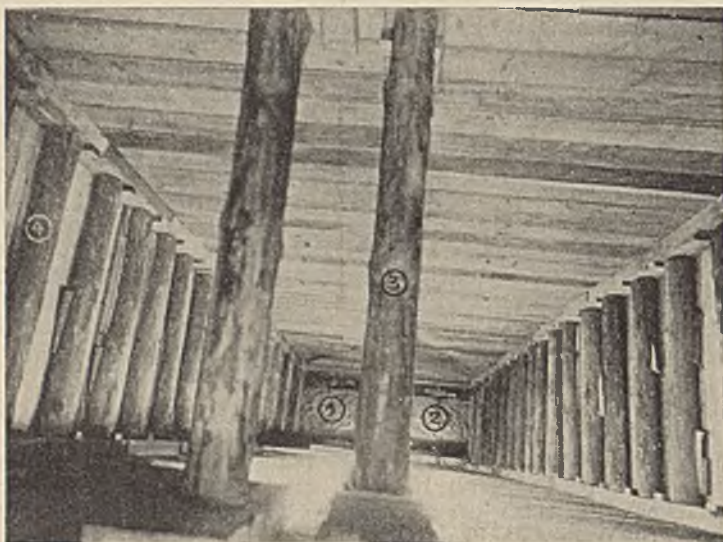
Abb. 4. Blick von oben in einen Schacht für die Parallelmauer. Die Sohle (1) ist bereits erreicht. Der schräg ausgeweitete Fuß ist durch eiserne Spindelsteifen (2) ausgesteuft. Der obere Schachtteil ist durch eine hölzerne Mittelsteifung (3) und hölzerne Außensteifung (4) gesichert.
