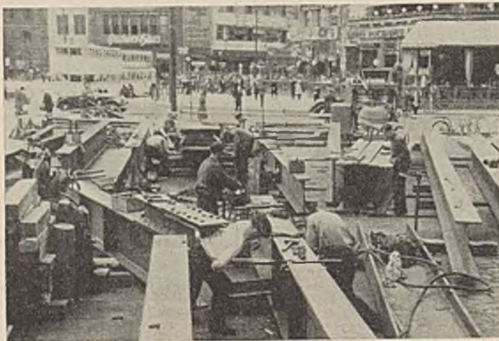
Abb. 8. Werkplatz für die Stahlkonstruktion der zwischzeitlichen Abfangung.
