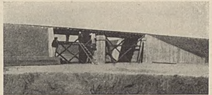
Abb. 3. Brücke von 2 × 7 m Öffnung auf der Strecke Fuka—Mersa Matrouh.
