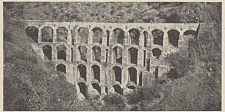
Abb. 1. Brücke der Eisenbahn Kalka—Simla.
