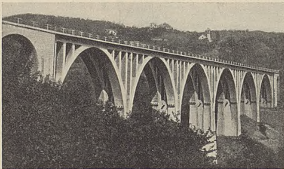
Abb. 14. Viadukt bei Montanesi.
