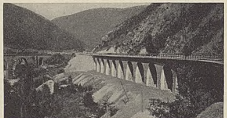
Abb. 8. Viadukt bei Mereta, der den Zweck hat den Straßenkörper von den zerbröckelnden Schichten des Abhangs fernzuhalten.
