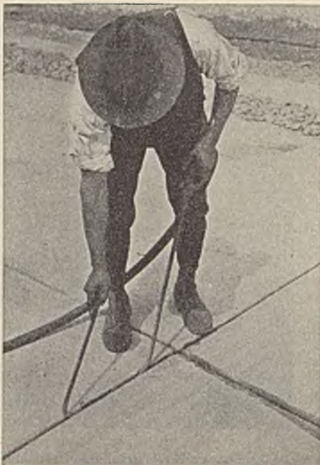
Abb. 20. Reinigen der Fugen mit Preßluft.
