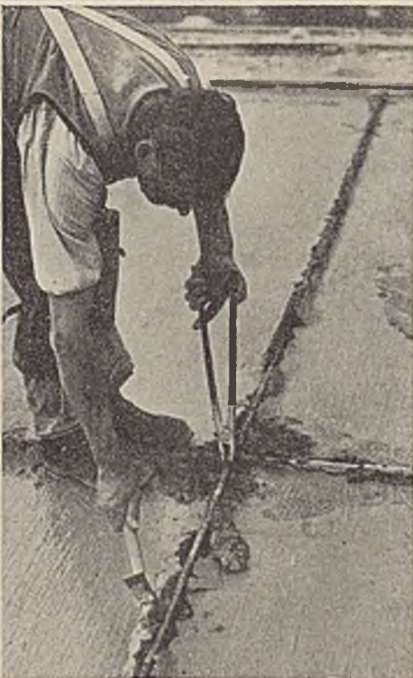
Abb. 7. Mangelhafte Fugenherstellung.
