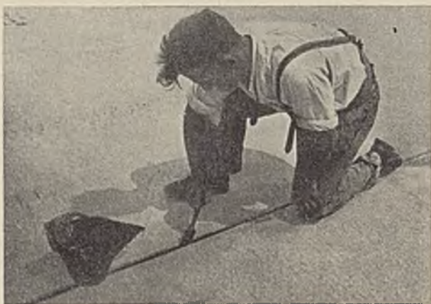
Abb. 21. Aufbringen des Fugenoranstrichs von Hand.
