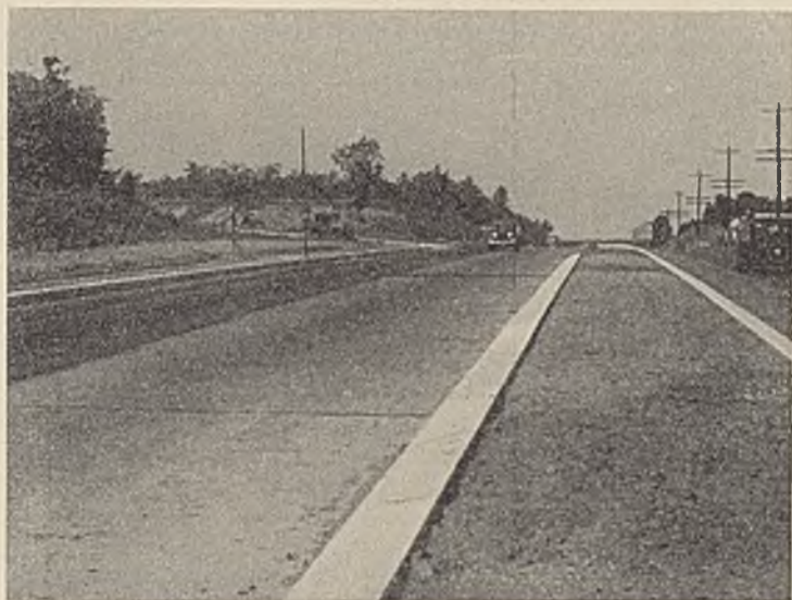
Abb. 5. Staatsstraße in New Jersey. Nachträglicher Einbau eines Mittelstreifens durch seitliche Verschiebung einer Betonfahrbahn von 3 m Breite.
