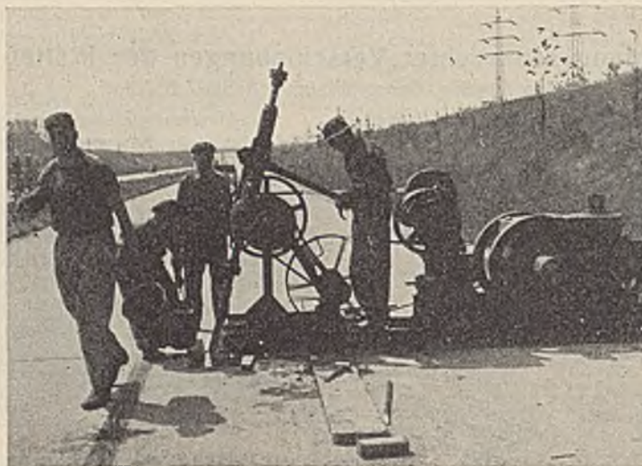
Abb. 4. Ausbohren des ovalen Dübelloches mit Kernbohrmaschine (Bohrsäule 60° geneigt).
