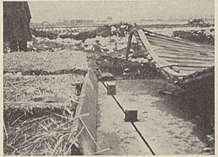
Abb. 3. Einsetzen der rechteckigen Blockdübel.
