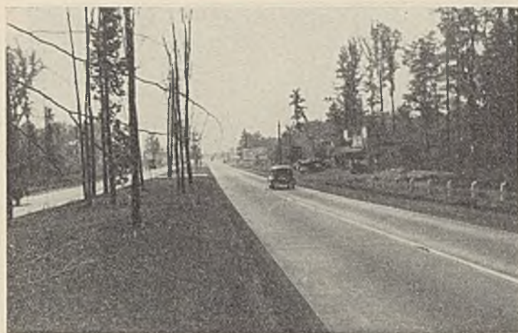
Abb. 4. Staatsstraße mit zwei Fahrbahnen in New Jersey (USA.).
