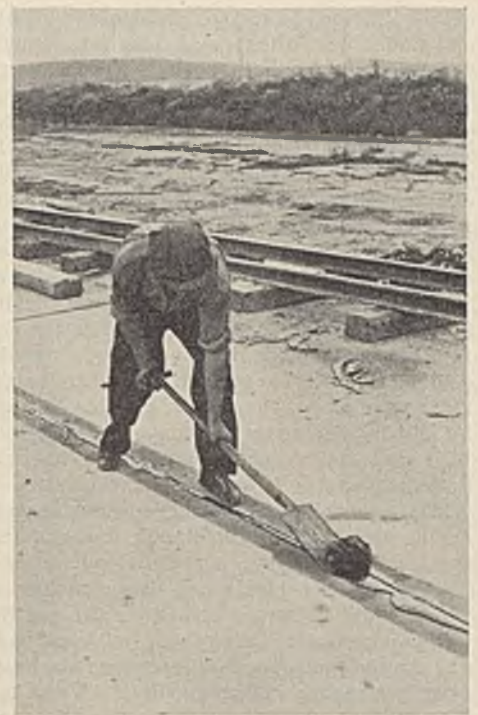
Abb. 26. Entfernen der überstehenden Vergußmasse (Lehmanstrich).
