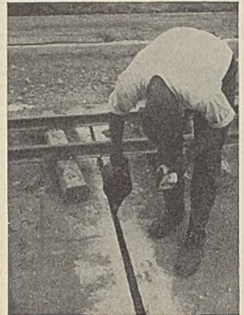
Abb. 23. Fugenverguß von Hand.
