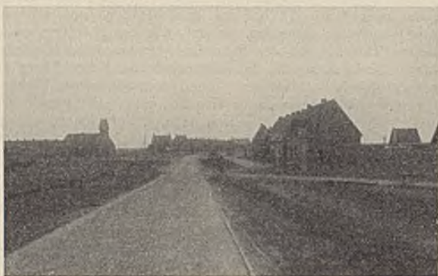
Abb. 1. Einspurige Straße im Wieringer Polder (Holland).
