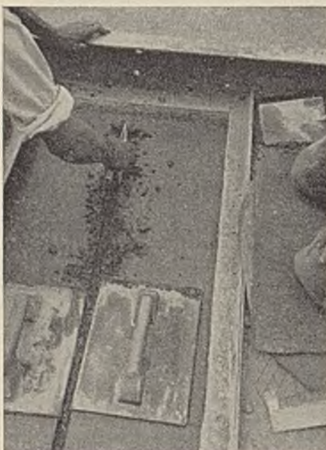
Abb. 11. Verfahren „Wieland“. Bearbeiten der Fugenränder.
