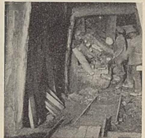
Abb. 8. Brust des Sohlstollens mit zerdrücktem Einbau.
