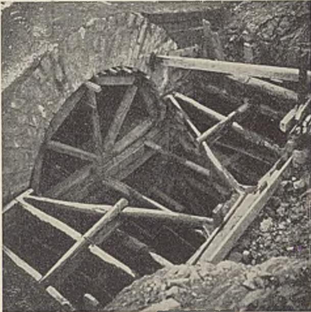
Abb. 5. Zimmerung für die Ausschachtung des ersten Ringes.
