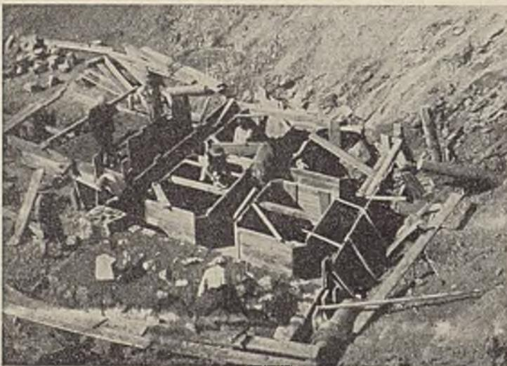
Abb. 3. Eisenbetonrahmen für die Ausführung des Portals in Schalung.
