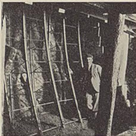
Abb. 10. Talseltiger Querschlag mit bewehrtem Widerlager. Betonierung bereits begonnen.
