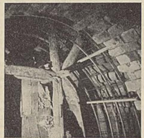
Abb. 15. Kalotte des Zwischenringes VII. Man sieht den betonierten Haupttring VI, Firststollenverstärkung, Abstützungswand und im Vordergrund die gemauerte Kalotte des Ringes 5.
