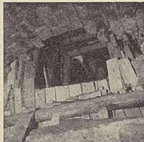
Abb. 12. Vortrieb des Firststollens vom gemauerten Firstgewölbe des Ringes 5 aus. Im Vordergrund die Abriegelung der Rutschungsmassen durch die Bohlenwand.
