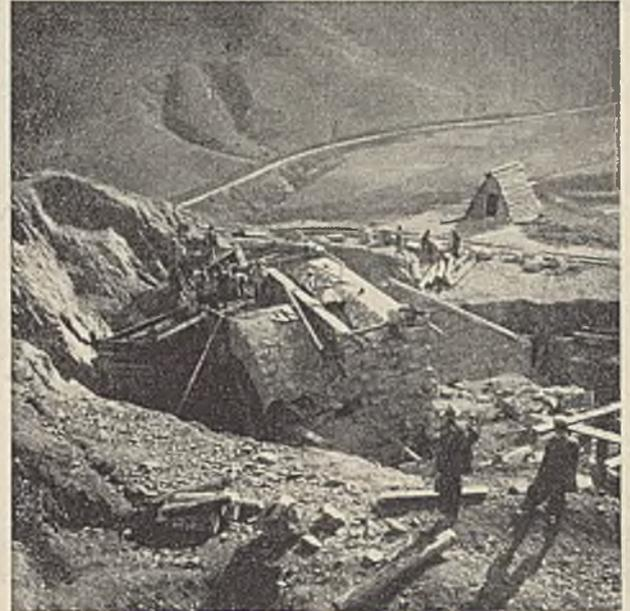
Abb. 4. Portalblock mit nahezu fertiggestelltem talseitigen Flügel.
