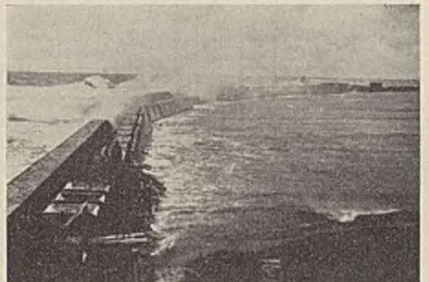
Abb. 11. Trotz des Schutzes der Brustmauer von der See in den Hafen geworfenes Gleis.
