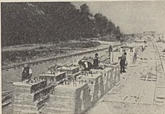
Abb. 8. An Land hergestellte Betongrundbettblöcke für ein Ankerfeld.
