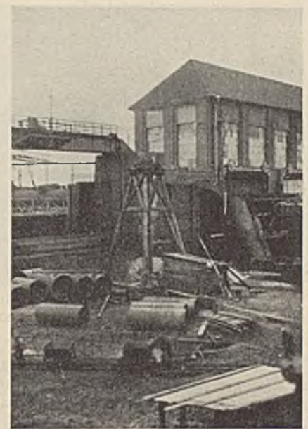
Abb. 5. Bohrung am Kraftwerk.
