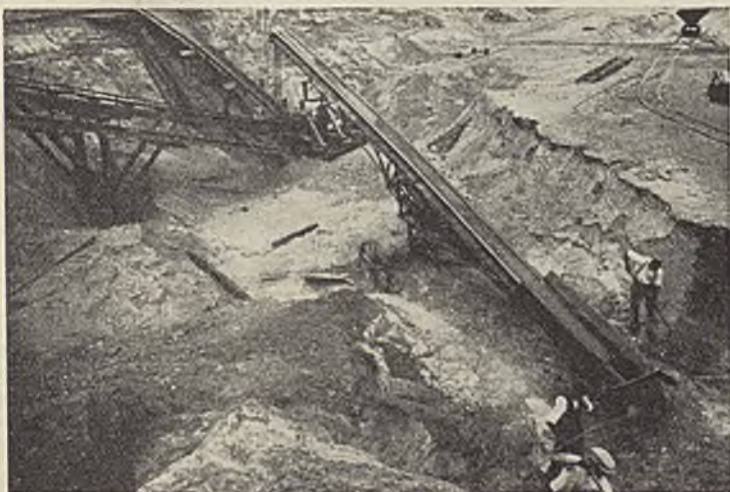
Abb. 1. Fahrbares Förderband (als Zubringerband) beim Beschicken eines ortsfesten Hauptförderbandes.
