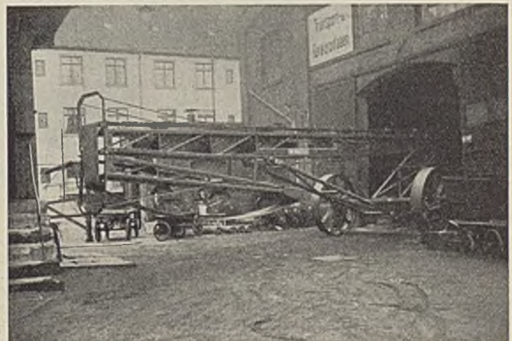
Abb. 3. Fahrbares Förderband mit eingeknicktem Abwurfende.
