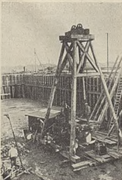
Abb. 8. Bohrung eines Großfilterbrunnens.
