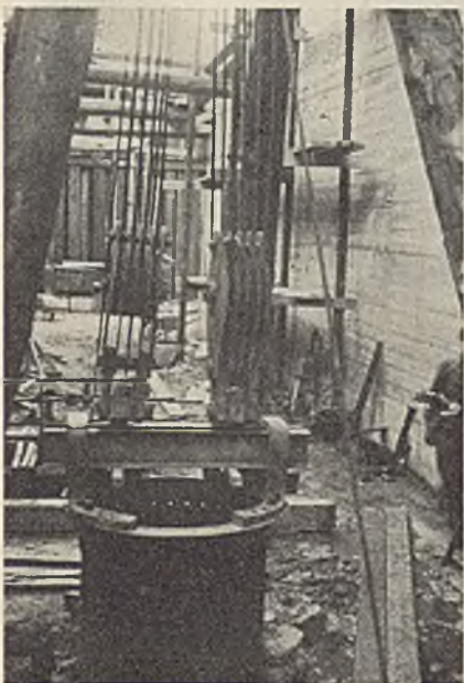
Abb. 18. Ziehen der Großbrunnen.
