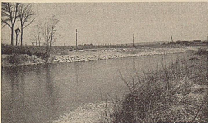
Abb. 50. Oberes Ende der Ammerkorrektion bei km 132,15, vom rechten Ufer gesehen.
