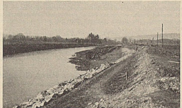
Abb. 48. Ammerkorrektion bei km 131,5 links. Im Vordergrund fertiger Bau, im Mittelgrunde Abgraben des Vorlandes.
