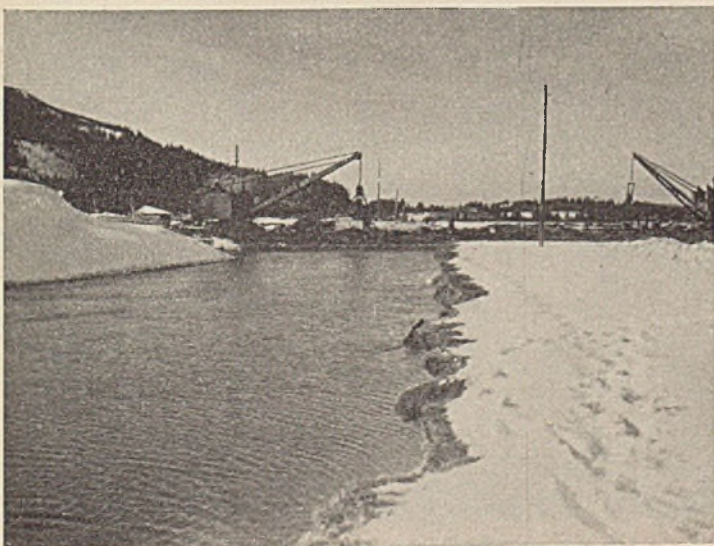
Abb. 38. Durchstich bei Ammer-km 9,3.
