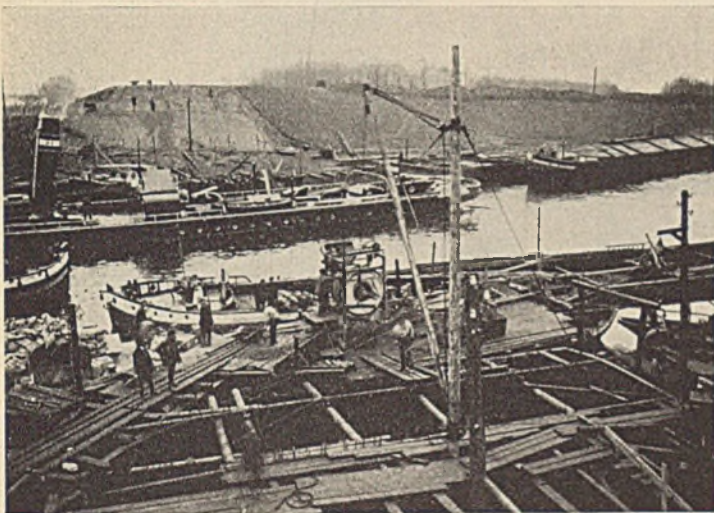
Abb. 7. Betonieren des westlichen Mittelpieflers.
