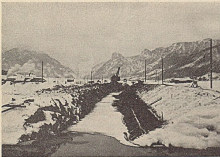
Abb. 37. Durchstich der Ammer bei km 9,5; rechts Anbringung der Berauhwehrung.
