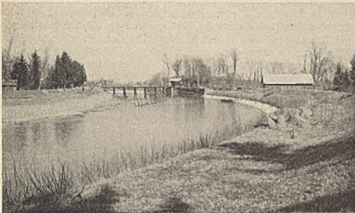
Abb. 46. Blick auf das untere Ende der Ammerkorrektion (km 131,3) gegen das Holzhofwehr. Rechts Uferschutzbau 1930, links neue Korrektion; im Fluß Pfähle eines alten Leitwerks.
