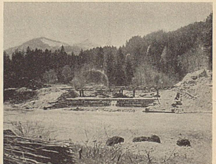
Abb. 44. Abschlußperre aus Holz an der Einmündung der Scherenaue Laine bei Ammer-km 10,3.
