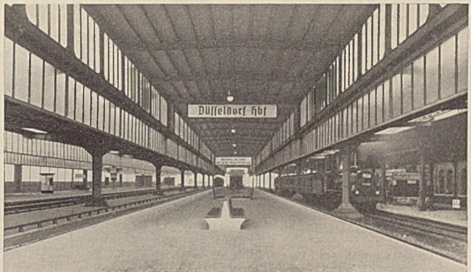
Abb. 9. Blick in die geschweißten Bahnhofshallen in Düsseldorf.
