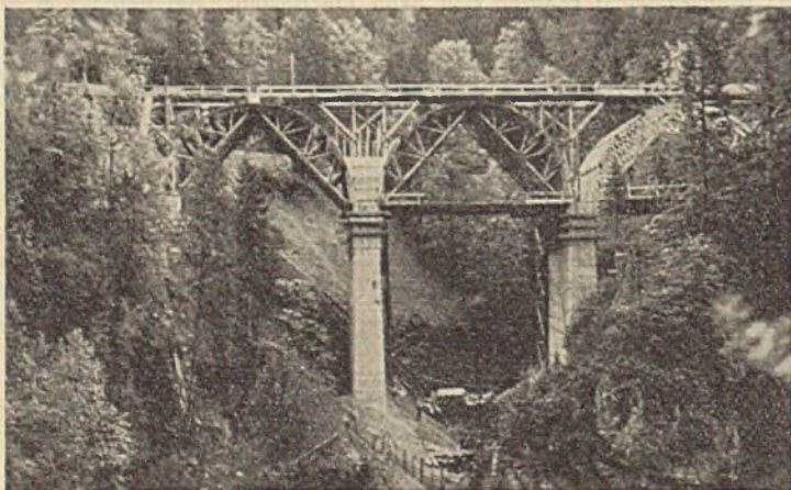
Abb. 16. Das fertige Lehrgerüst.
