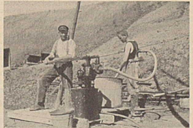
Abb. 10. Einpressen von Zementmilch mittels Handpumpe.
