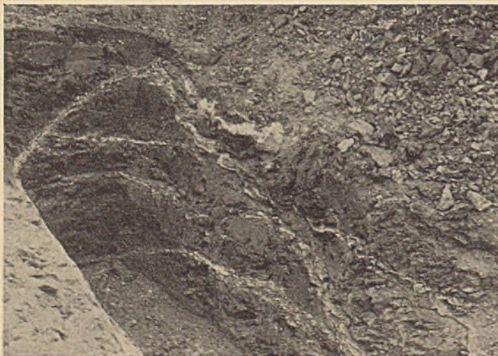
Abb. 12. Schürfgraben im verfestigten Ton mit Zementausfüllung der Klüfte.
