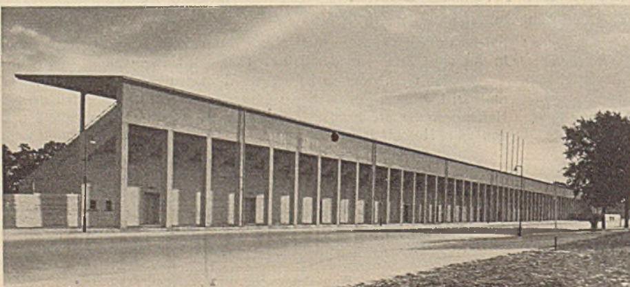
Abb. 7. Ansicht zum Messedamm.
