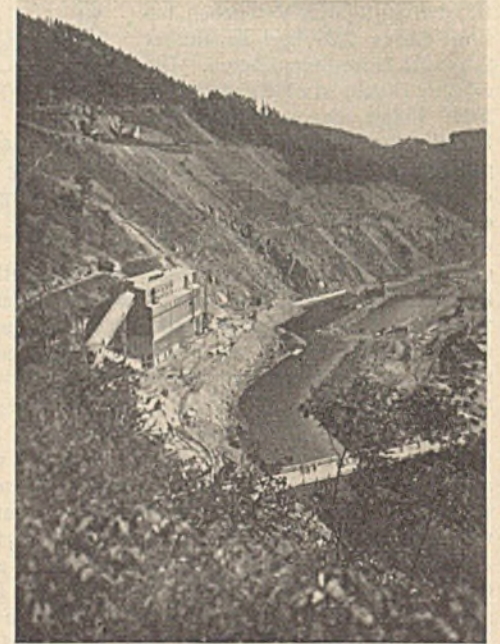
Abb. 1. Ansicht der Baustelle bei Hohenwarte.
